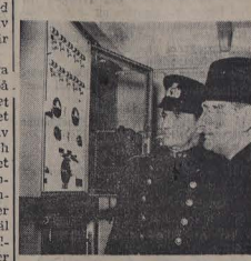
Inför representanter för fartygsinspektionen och brandväsendet inspekterades den första anläggningen i sitt slag i Sverige, nämligen en automatisk brandalarm enligt ett nytt svenskt system (Tidner) ombord på motorfartyget G-tland. Inalles 184 värmekontakter, fördelade på 10 sektioner och placerade i varje hytt och avdelning, är förbundna med centralapparaten - det registrerande organet - med elektriska ledningar. Bilden visar kommerserådet H. Sjöholm i fartygsinspektionen och brandkapten William Palmqvist i Stockholms Brandkår framför alarm apparaten.
