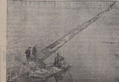
VÄRFLOD I BELGIEN. Vårfloden har satt stora områden i Belgien under vatten. Här är arbetare i färd med att gräva ett avloppsskär för att där igenom avleda en del av de hotande vattenmassorna.
