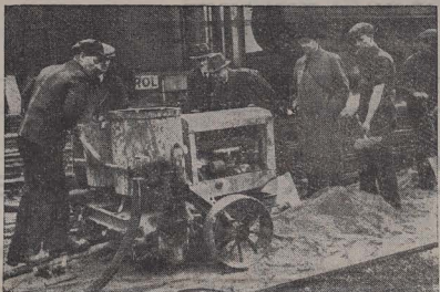
BROEXPERTER FRÅN SJÄLLAND. I England. Byggnadsarbetarna John Björk och byråingenjör Sten Rein, på broavdelningen vid Statens Järnvägars tekniska byrå är på studiebesök i England och ses här titta på en maskin, som fyller igen håligheter i bannell.
