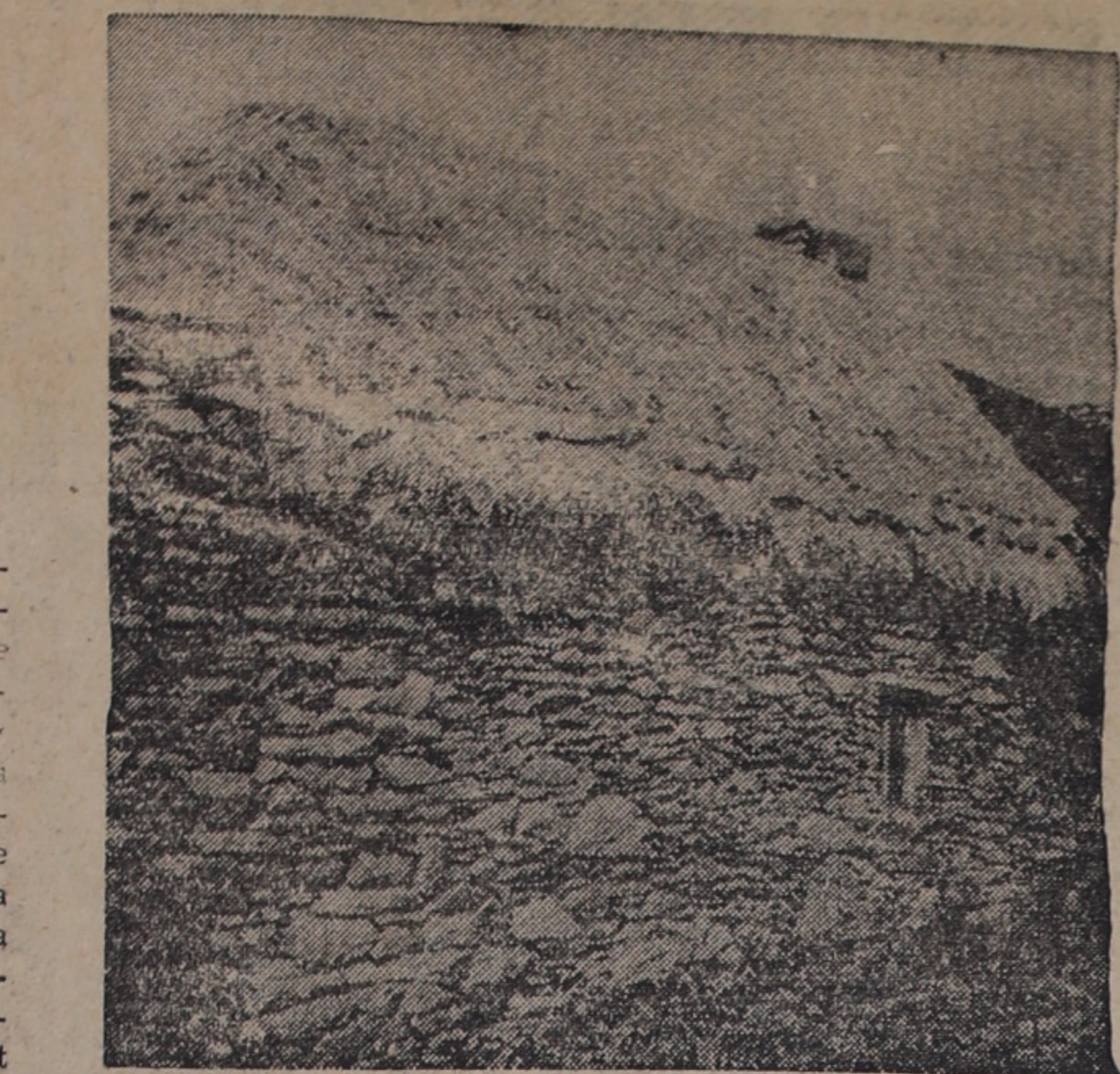
Stall för mula och åsnor, byggt av sten utan murbruk, med tak av halmtak. Mycket billigt att bygga.
