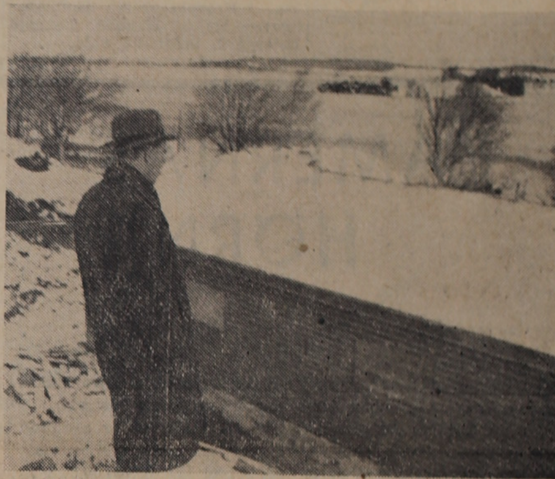
Nämndeman Einar Pålsson blickar ned på pumpstationen.
