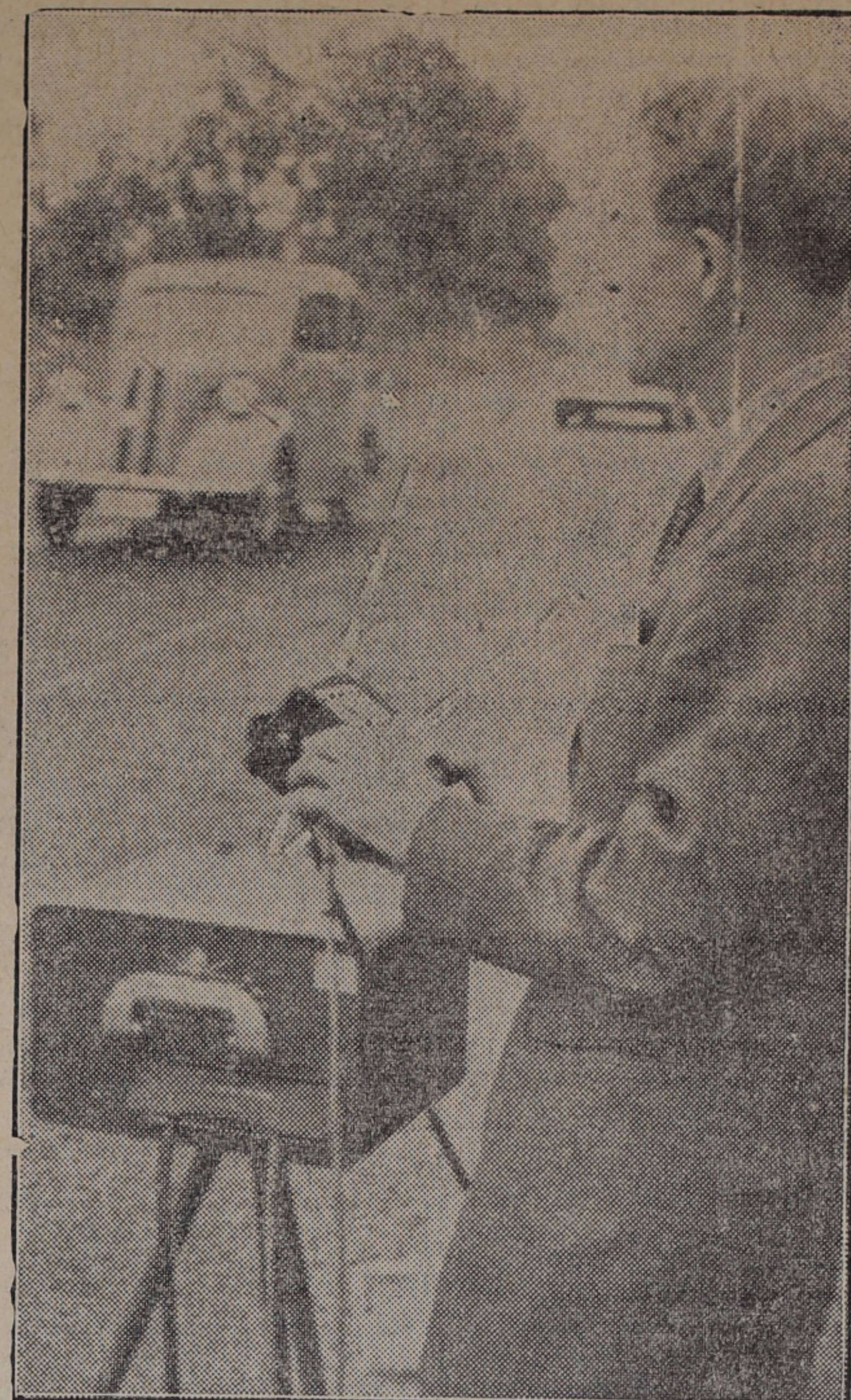
Det här är ett nytt vapen mot fartidarna. I den här lilla lådan avläser polisen ögonblickligen hur fort ni kör inom den vitprickade sektorn. Här visar Ök. Gunnar Dahlberg, Göteborg, hur apparaten fungerar.
