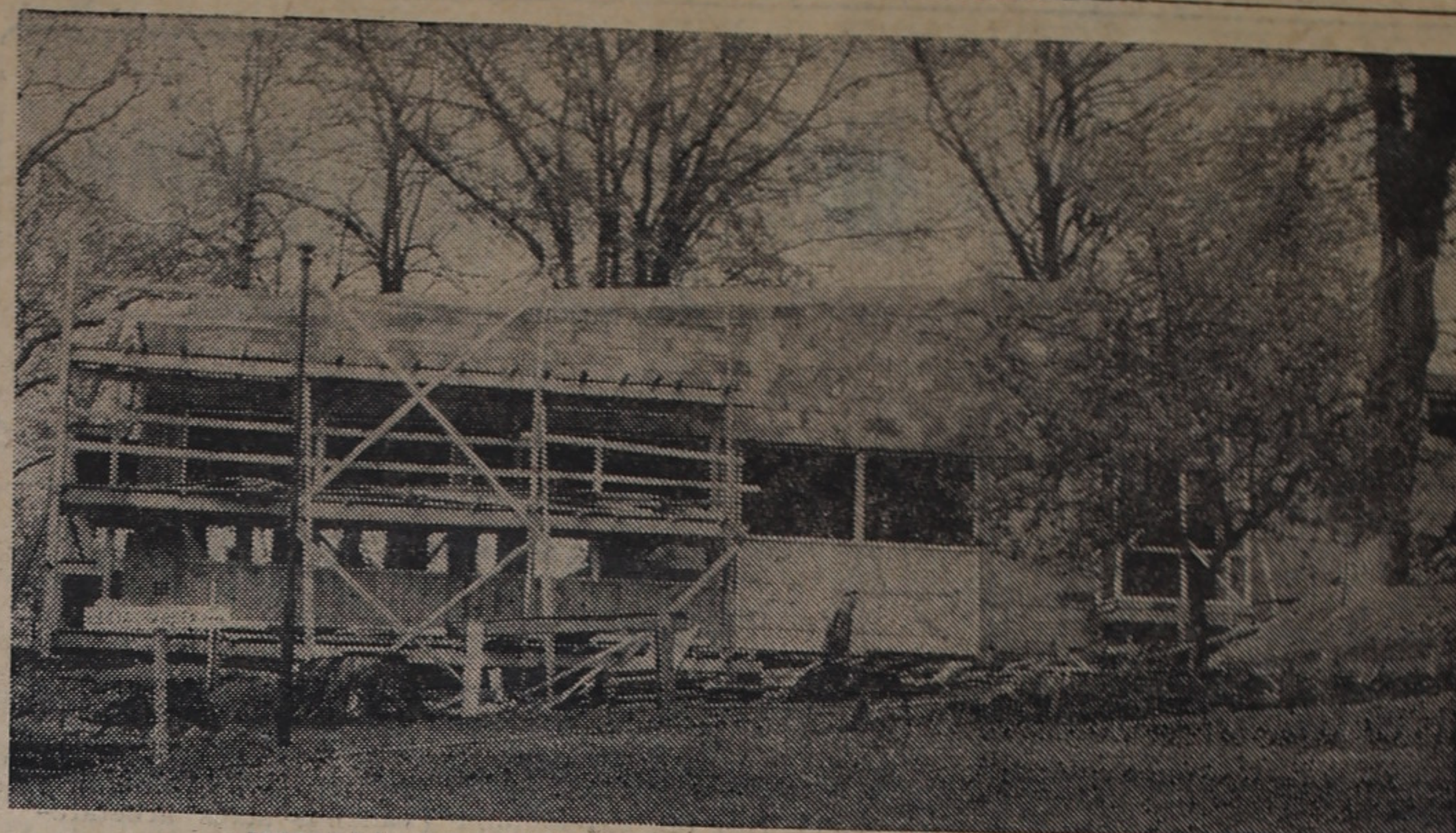
HOTELLPAVILJONGENS ytterväggar börjar få den första putsen.
