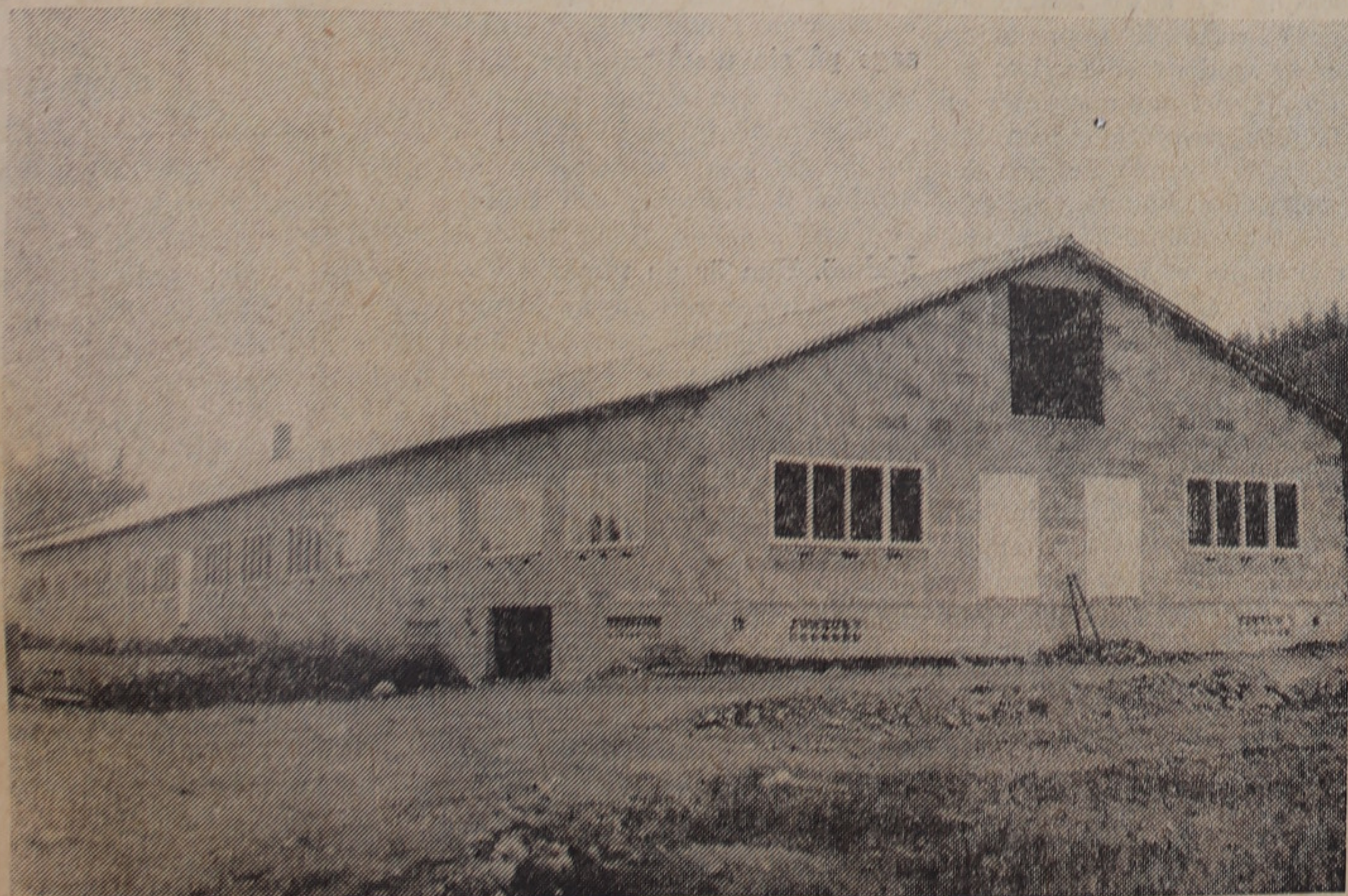
Knäreds största industribyggnad, fabrikkör Nils Gustavssons stora nybyggnad, närmar sig snart sin fullbordning och till jul bör det vara klart. Här en bild från den pampiga byggnaden, som har ett vackert läge mellan Laholmsvägen och Lagan.
