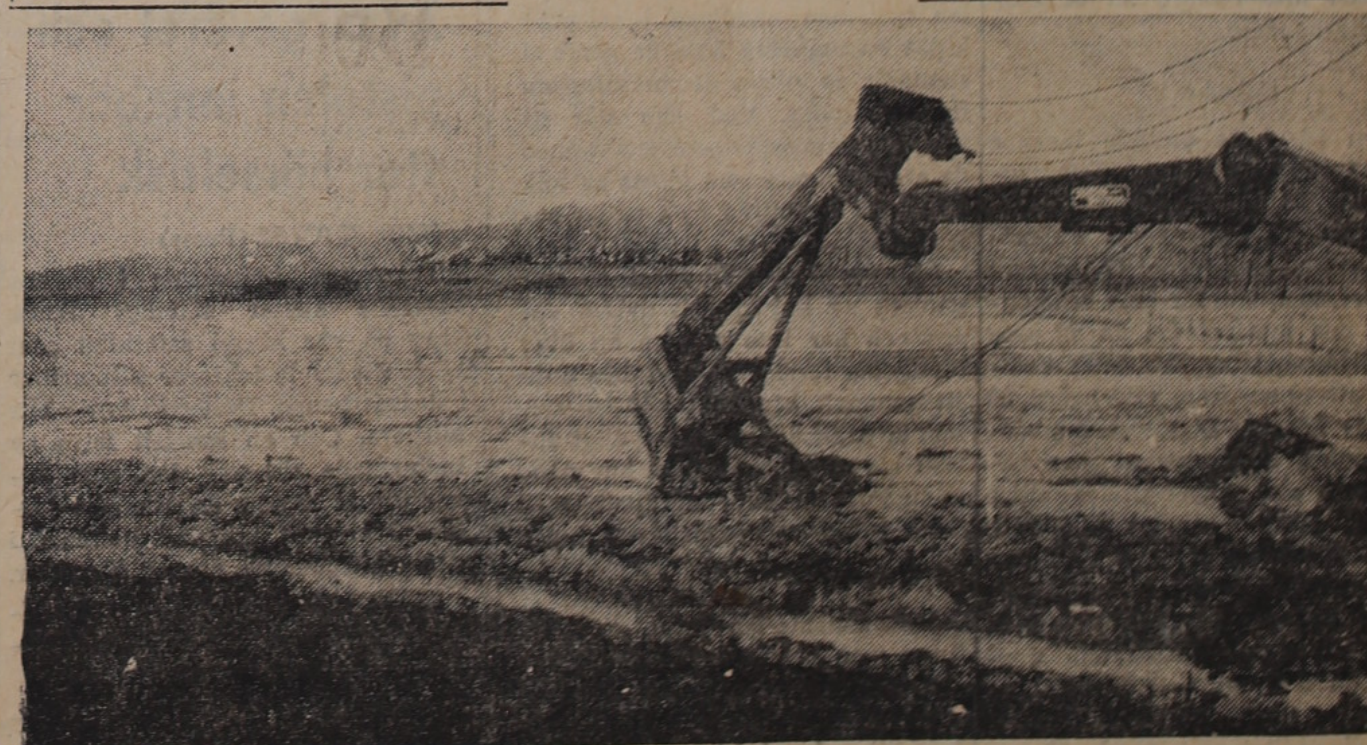
Trots det dystra översvåmningsläget vid Suseån inger grävmaskinerna hopp om bättre förhållanden i framtiden.
