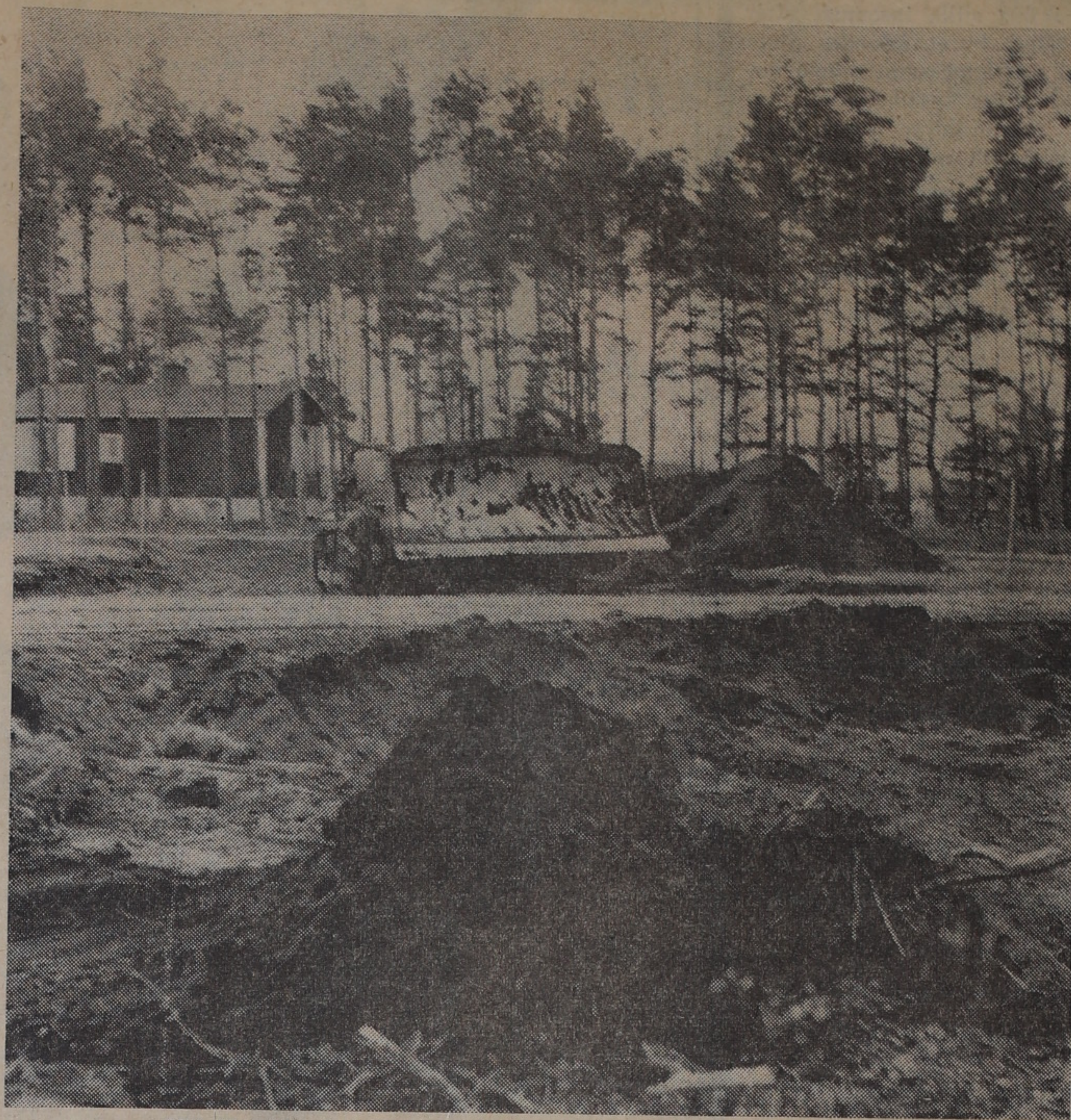
Vid Ekasjö arbetar caterpillaren på att göra an slutningsvägar.
