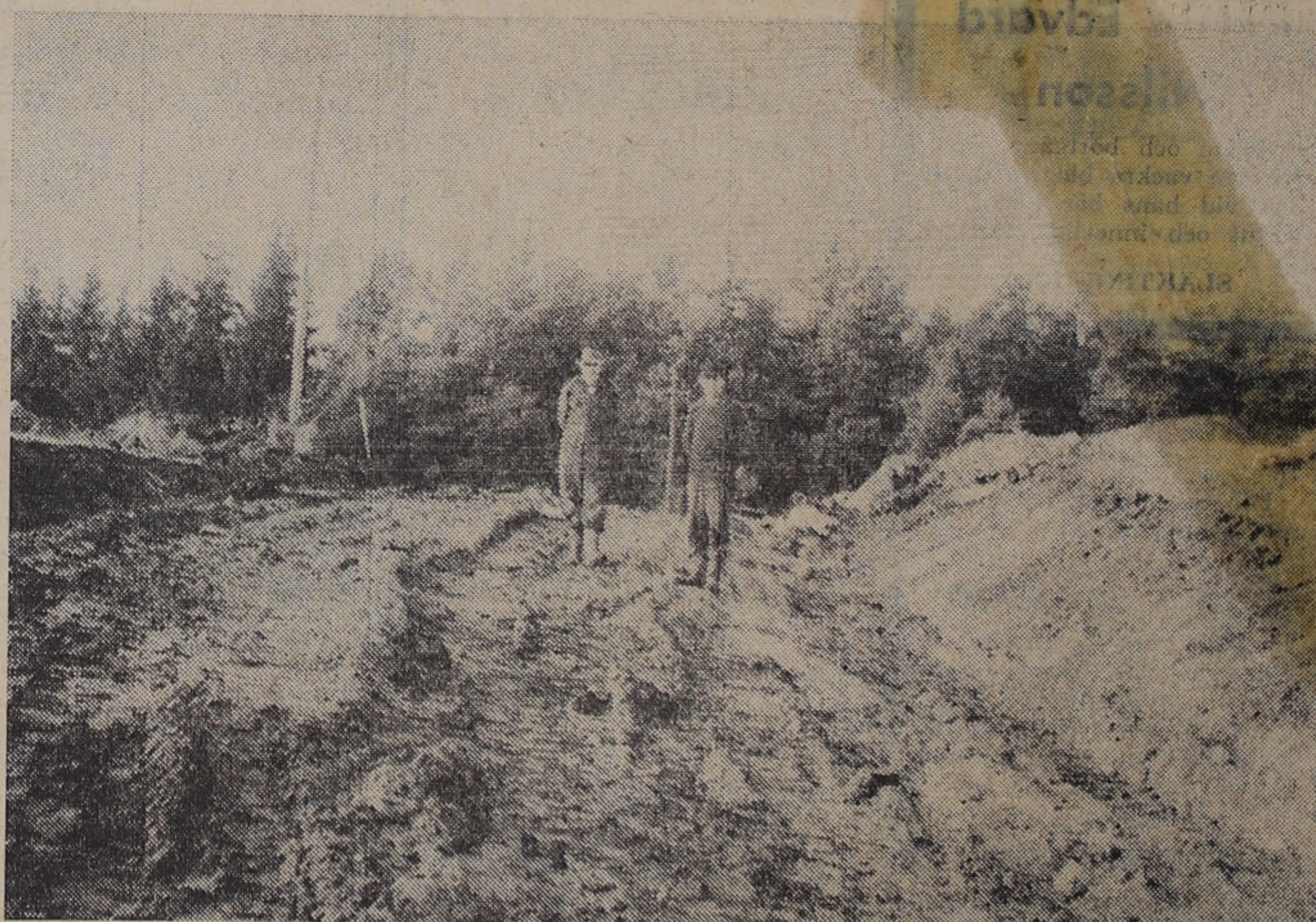
Entreprenören Lennart Hakansson och vägsamfällighetens ordf. Johan Bengtsson studerar en bit helt ny väg.
