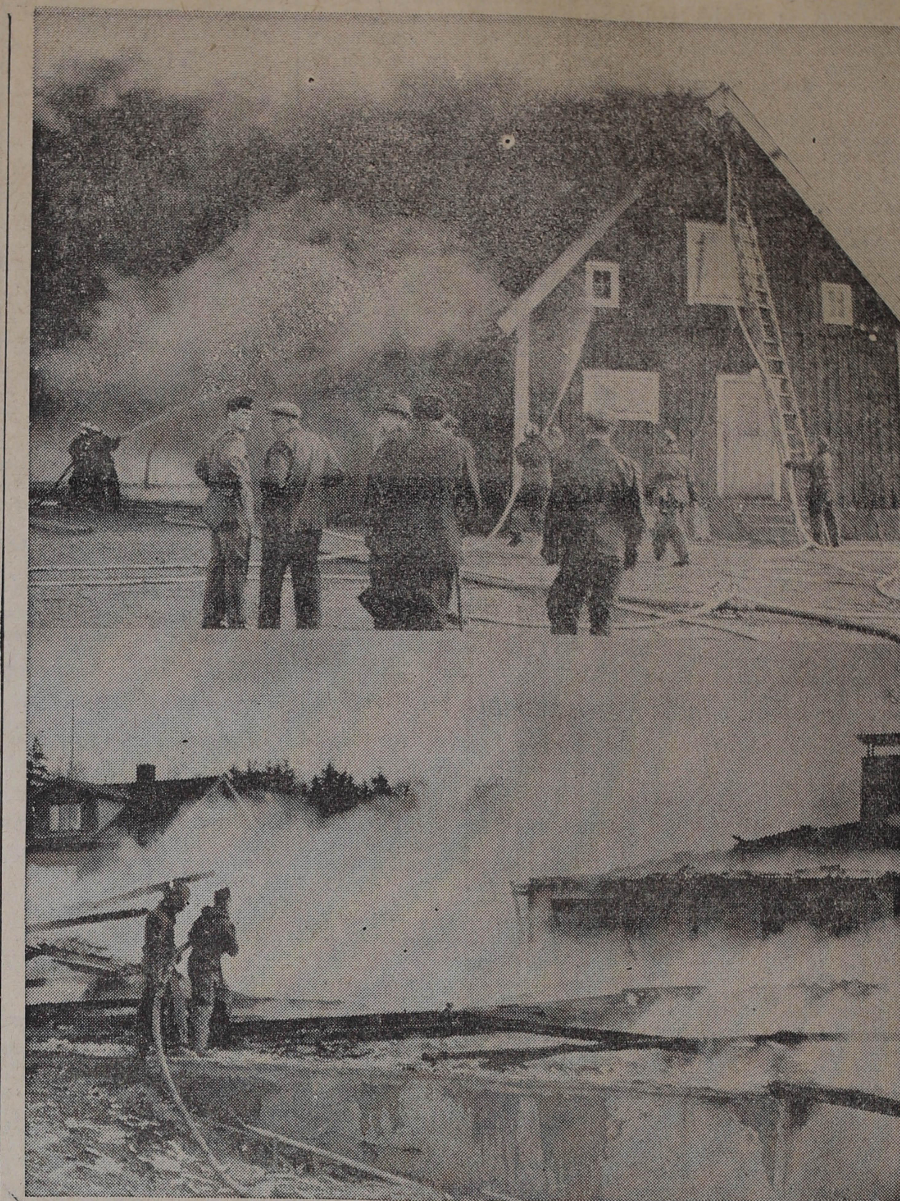
Brandmännen hade ett besvärligt arbete med att begränsa elden i den starka blåsten. På den översta bilden syns de i full aktion med släckningen i Enslöv, medan den undre bilden visar vad som efter en stund återstod av den antända byggnaden i Skedala.
