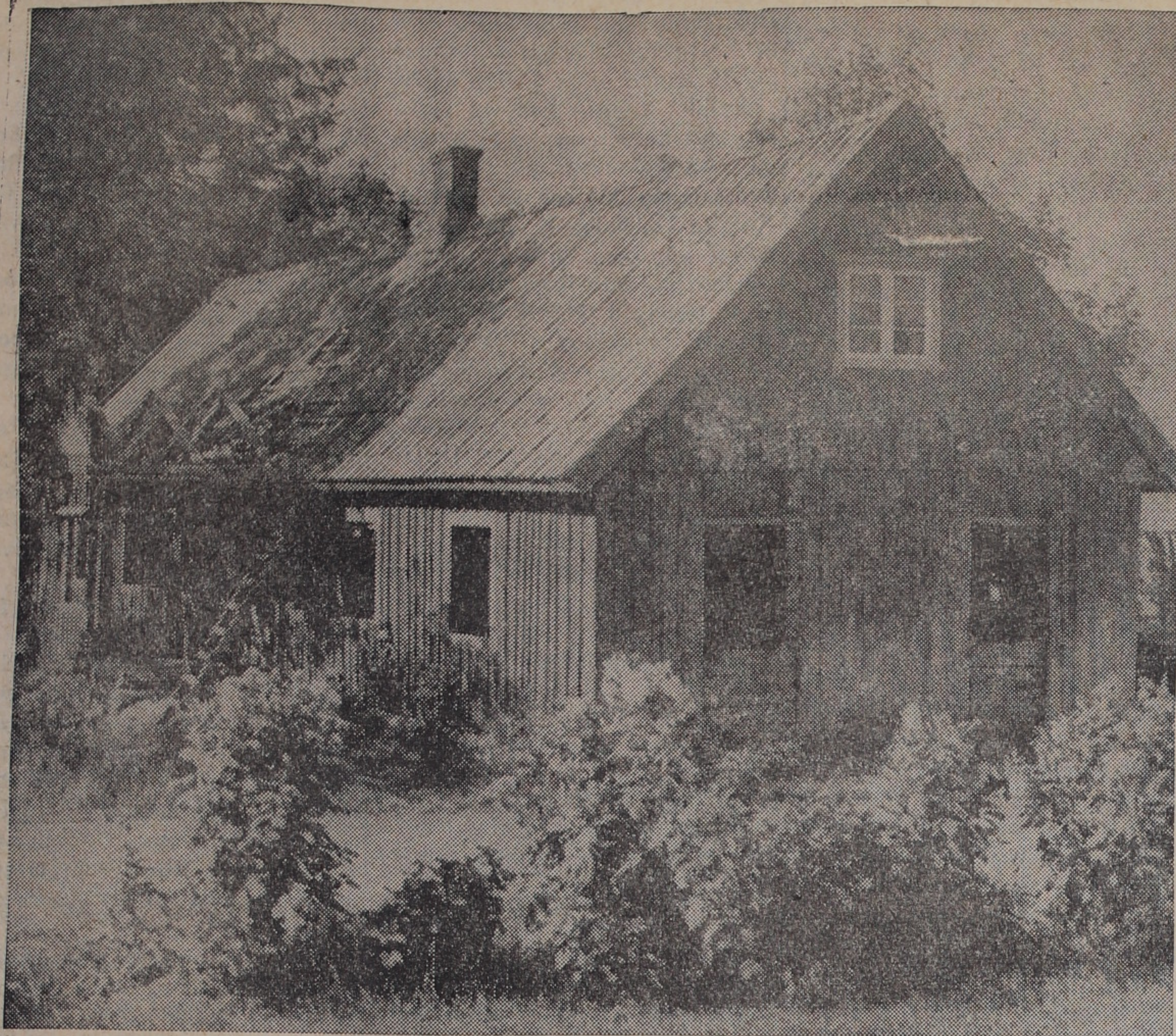
Rivningen har redan börjat av gamla gästgivaregården i Knäred
