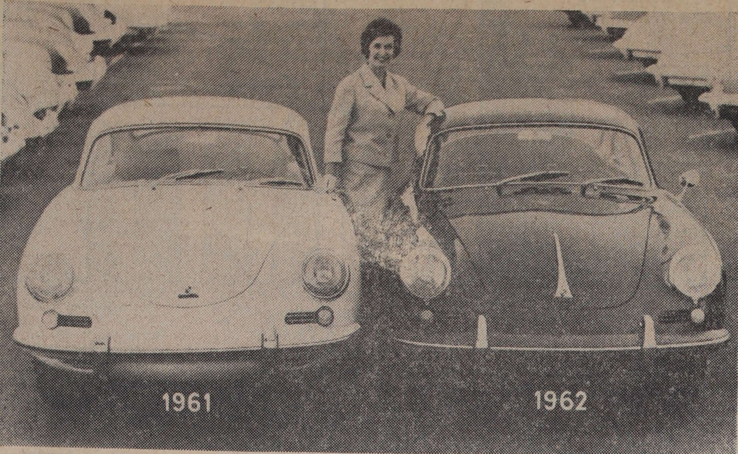
Porschemodellerna har fått en ansiktslyftning i höst genom större vindruta och bakruta, större framhuv, friskluftintag framför vindrutan, utvändigt bränslepåfyllning genom höger framflygel samt dubbla luftintag i motorluckan.
