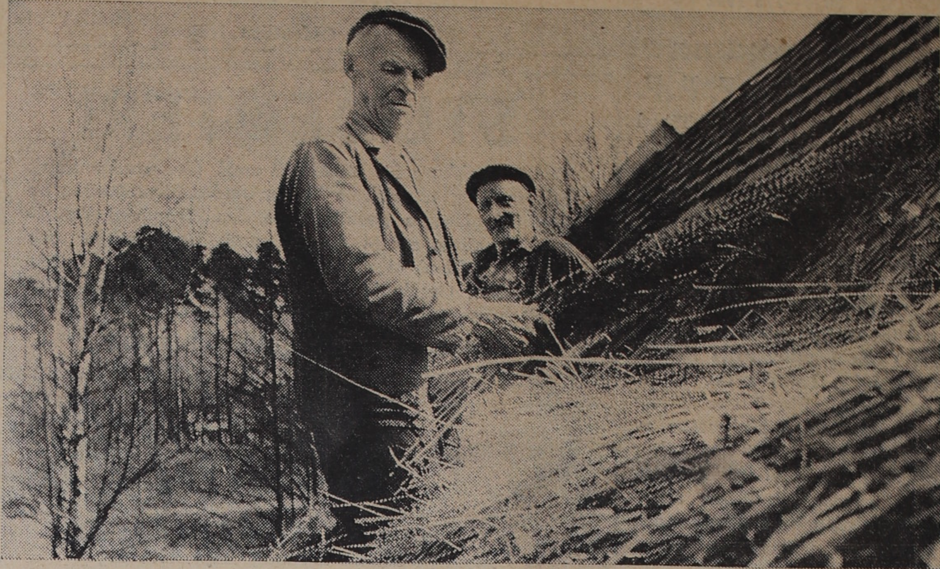
Johan Nilsson i full fart med täckningen av taket. I bakgrunden skymtar hans medhjälpare Evald Larsson
