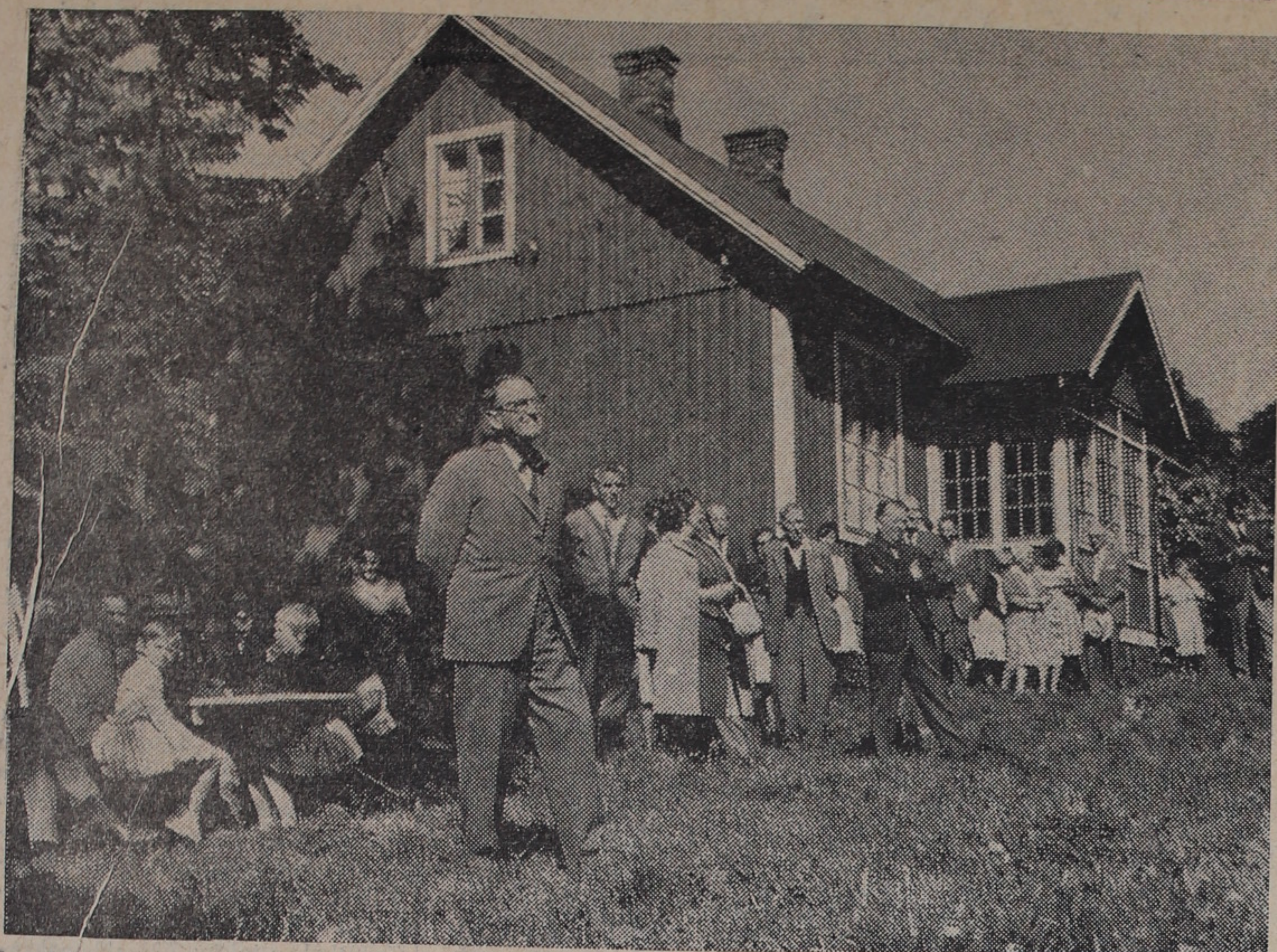
Landshövding Ingvar Lindell framför den gamla skolbyggnaden i Timmershult, som nu officiellt har ännits som Skid- och Friluftslivskommitténs "paradis".
