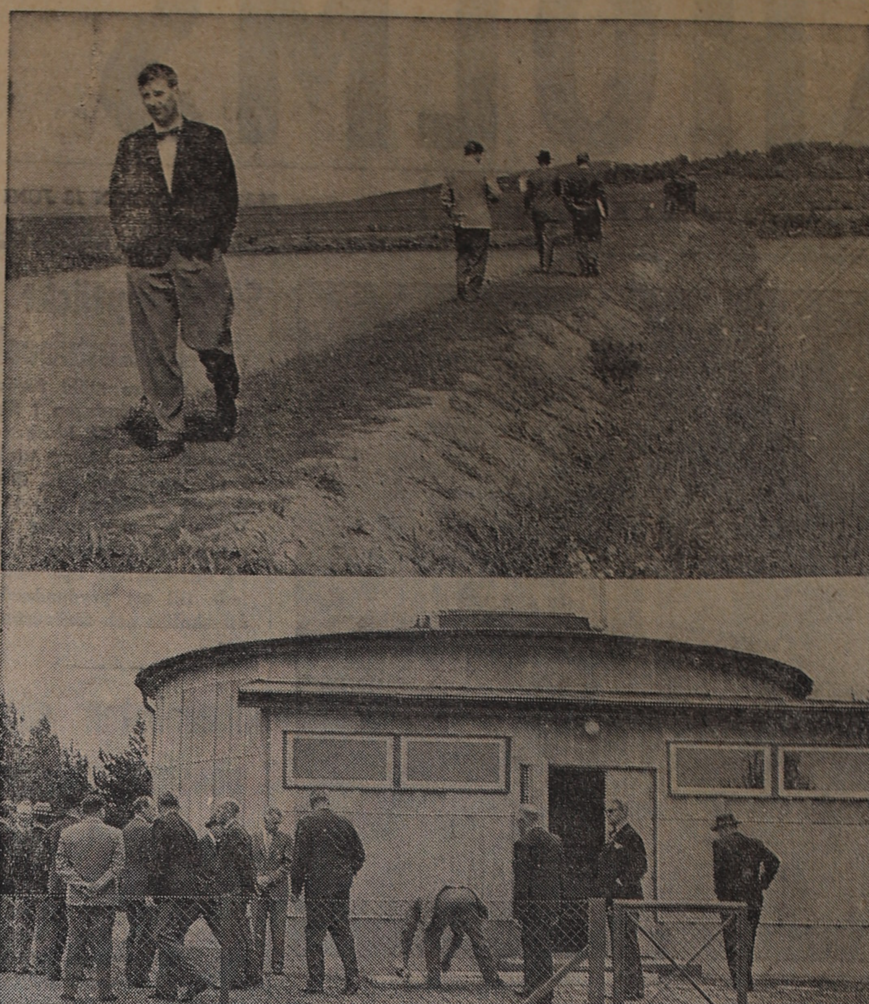
Överst: Det nya reningsverket med ett par dammar synliga. Därunder det nya vattenverket föremål för beskådande.
