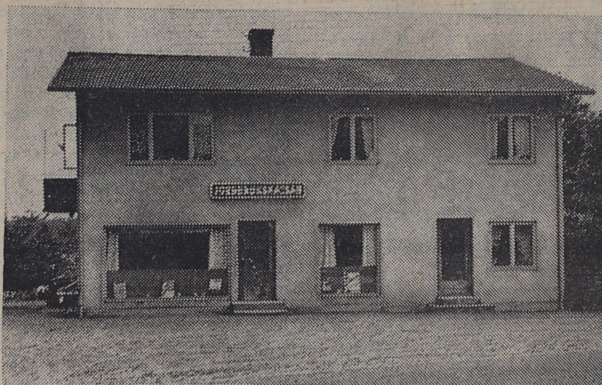
Jordbrukskassans fastighet i Våxtorp.
