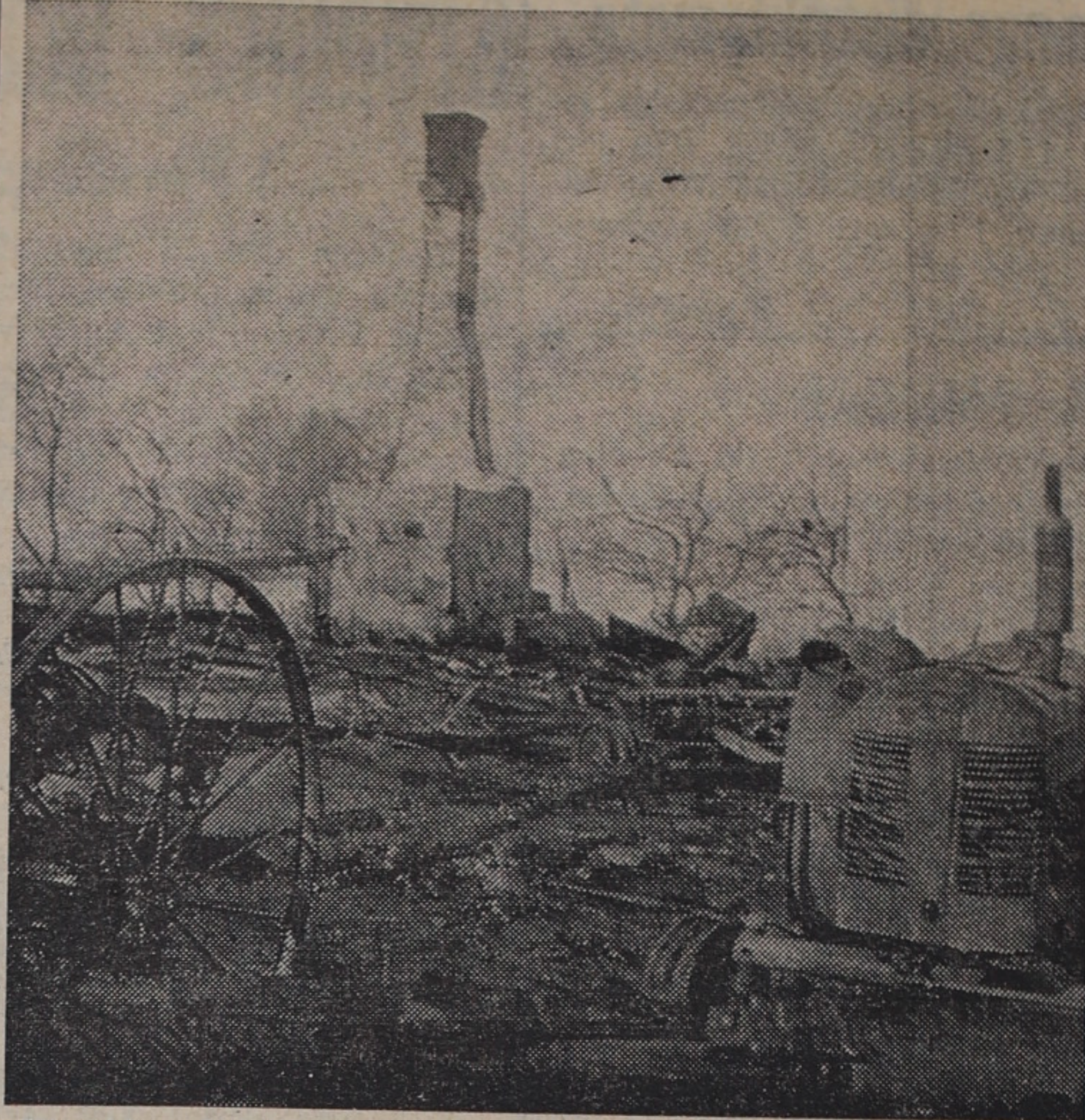
Förvridna skelett av en traktor och hästräfsa samt skorstensmuren var det enda, som återstod efter branden i Göstorpshult.
