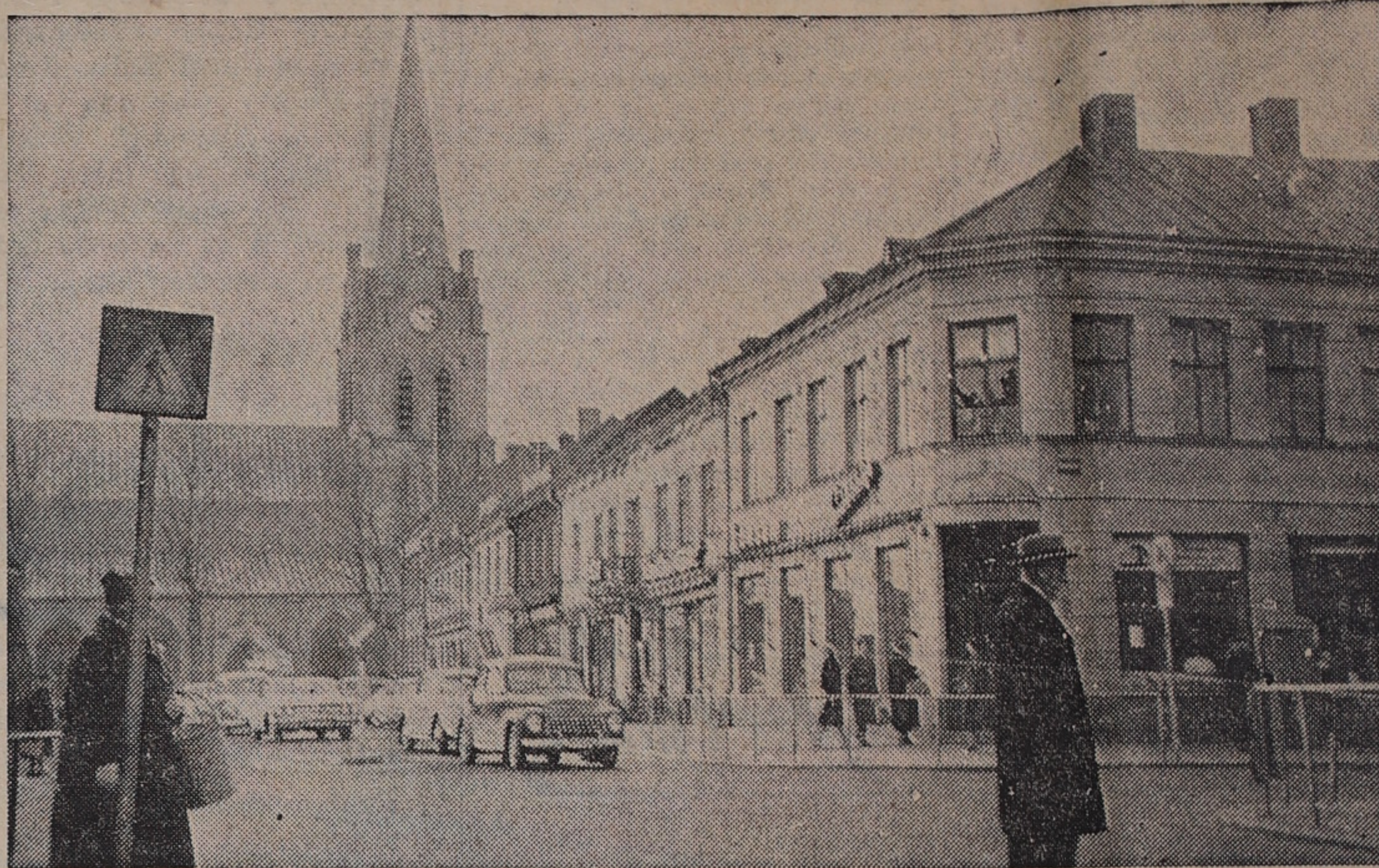
Hörnfastigheterna t h på bilden en del av f d Konsums fastigheter vid Stora torg, som överläts till Bezeliska Stiftelsen i samband med att Konsum förvärvat stiftelsens fastigheter vid motsatta sidan av torget för det blivande varuhuset.
