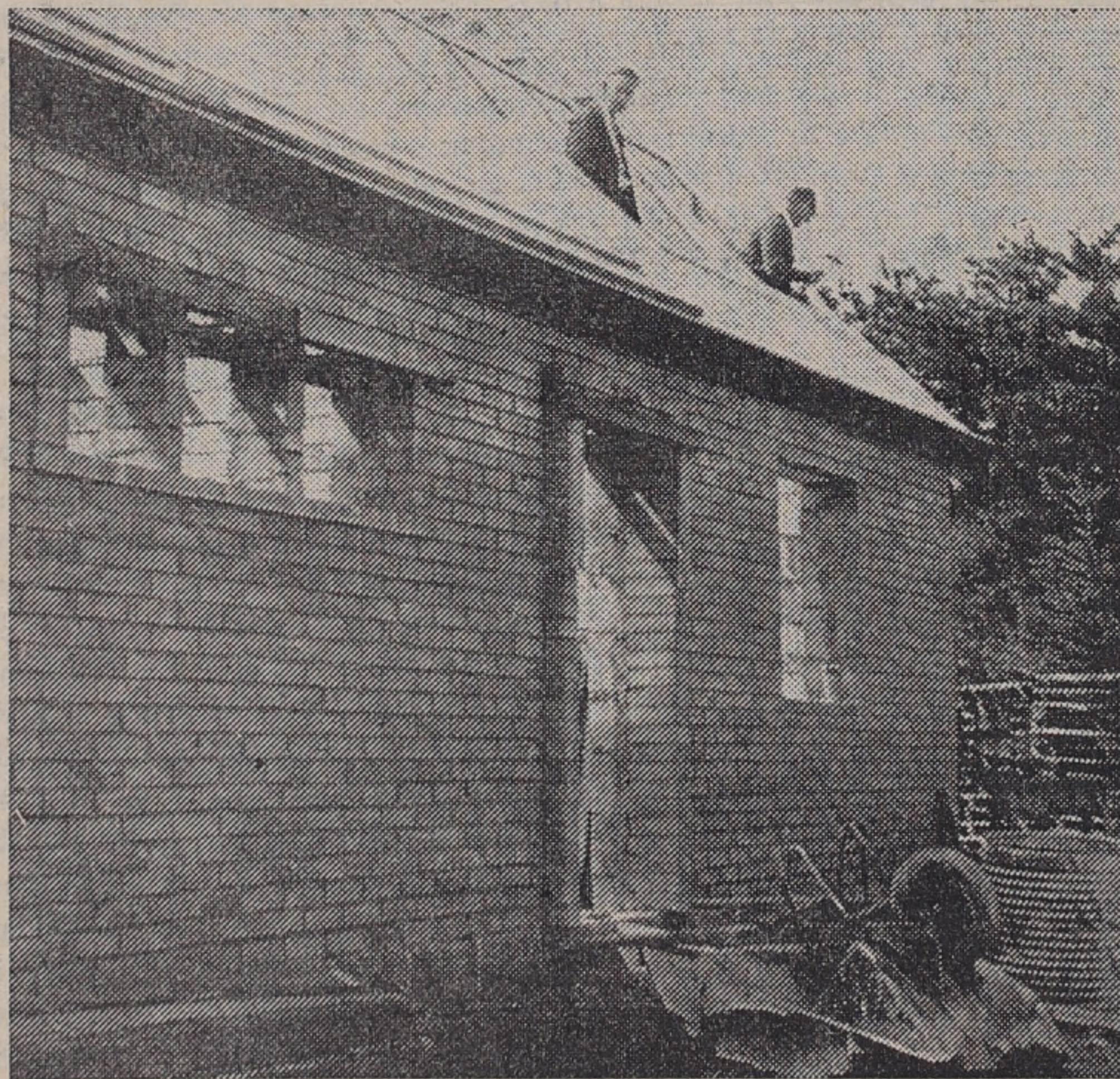
Byggnadsingenjör Stig Bjarle, Trelleborg, med sonen i full fart med att spika taket
