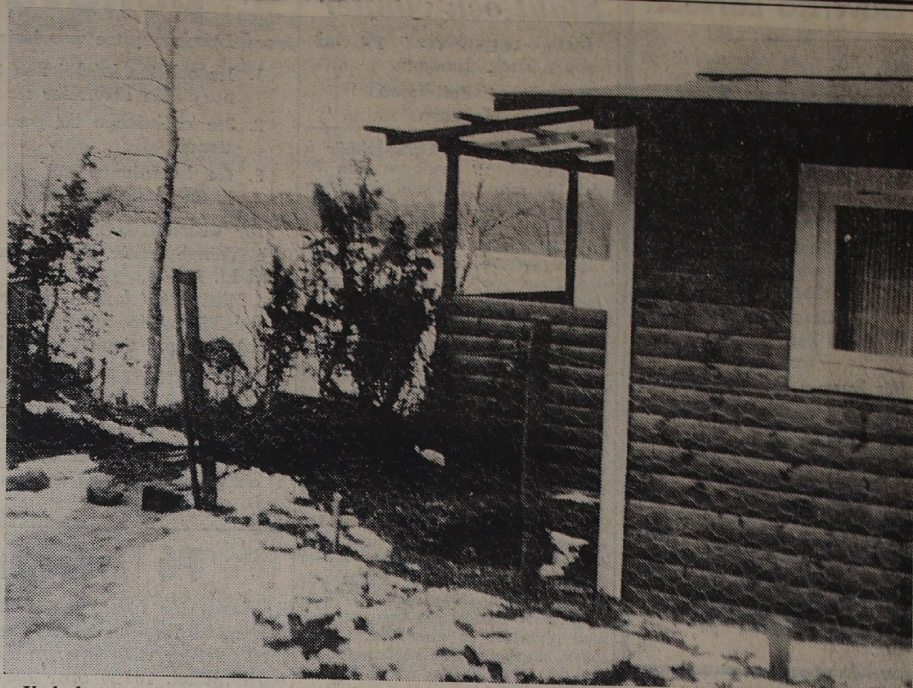
Underbart vackert ligger en liten sommarstuga vid fångdammen vid Knäreds övre kraftstation. Den får väl ligga kvar, men flera får inte byggas så nära Lagan — det är väl bara 30 å 40 meter dit och det måste vara minst 100 m.
