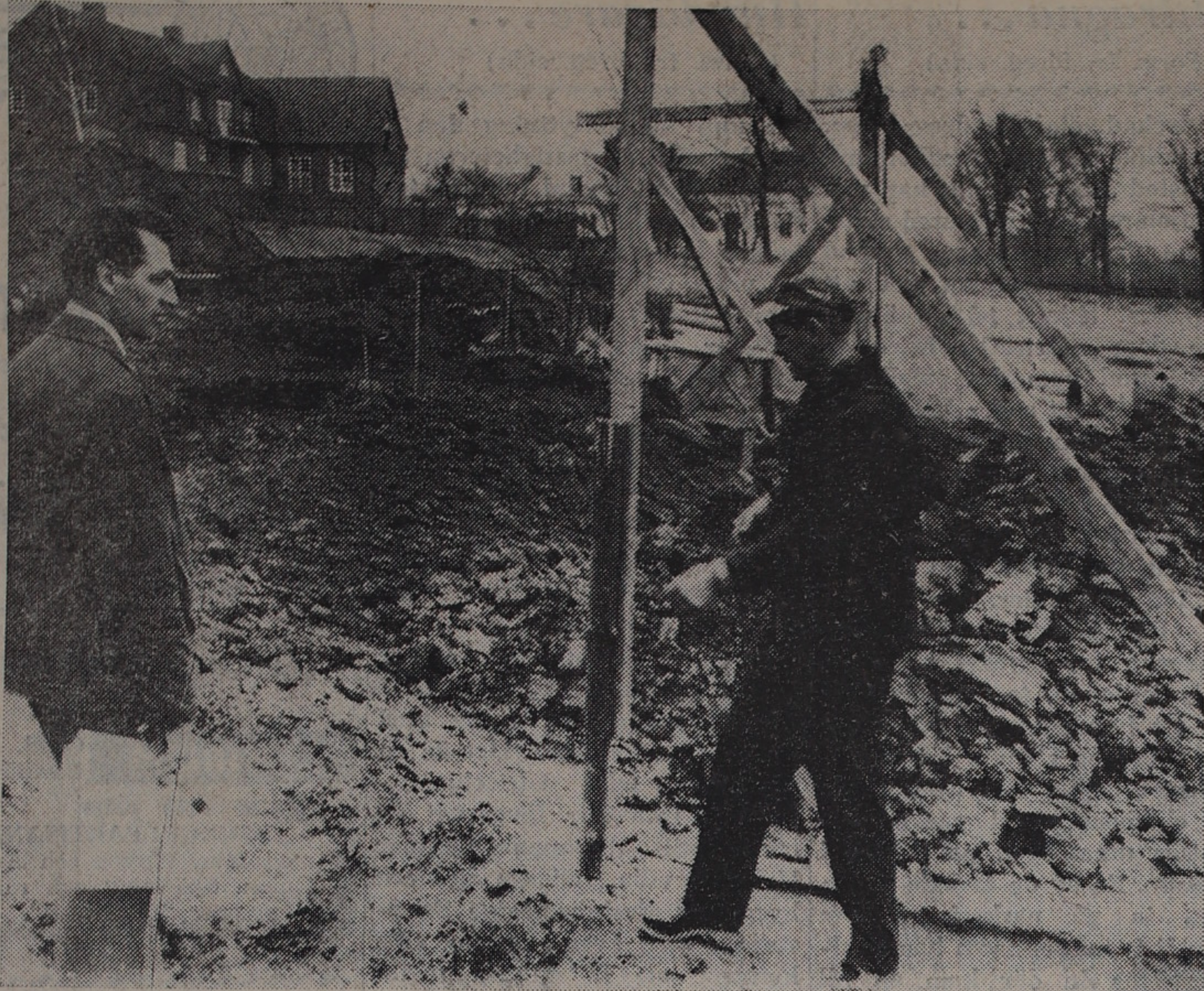
Rörledningsentreprenör Erik Olofsson och byggnadsingenjör Karl Ove Bengtsson diskuterar byggnation på slätten ned mot Lagavägen.
