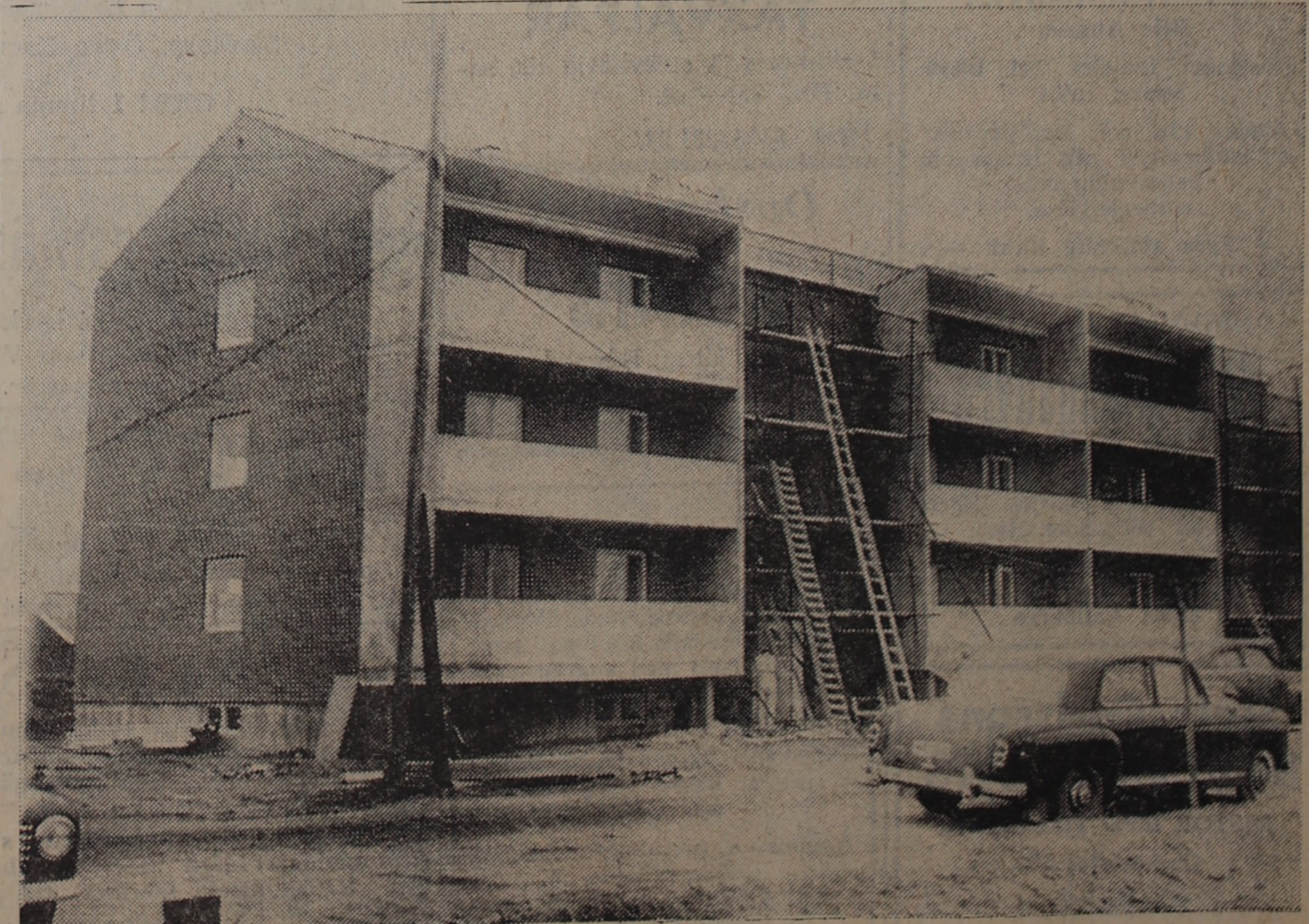
Glänningehuset är så långt att det knappt går in på en normal tidningsbild och därför har fotografen nöjt sig med att ta den tredjedel längst mot söder, som är inflyttningsklar i dagarna.
