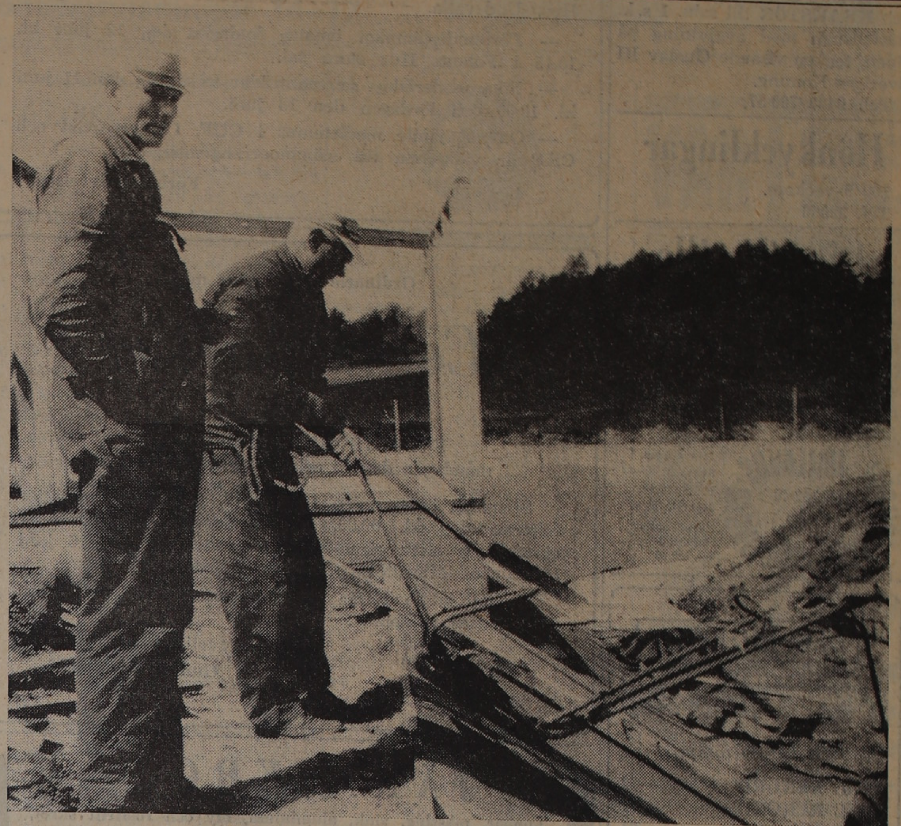
Entreprenör Oskar Svensson i Knäred tittar ut över ringkanalen i Våxtorp, där hans mannar just nu gjuter slänterna
