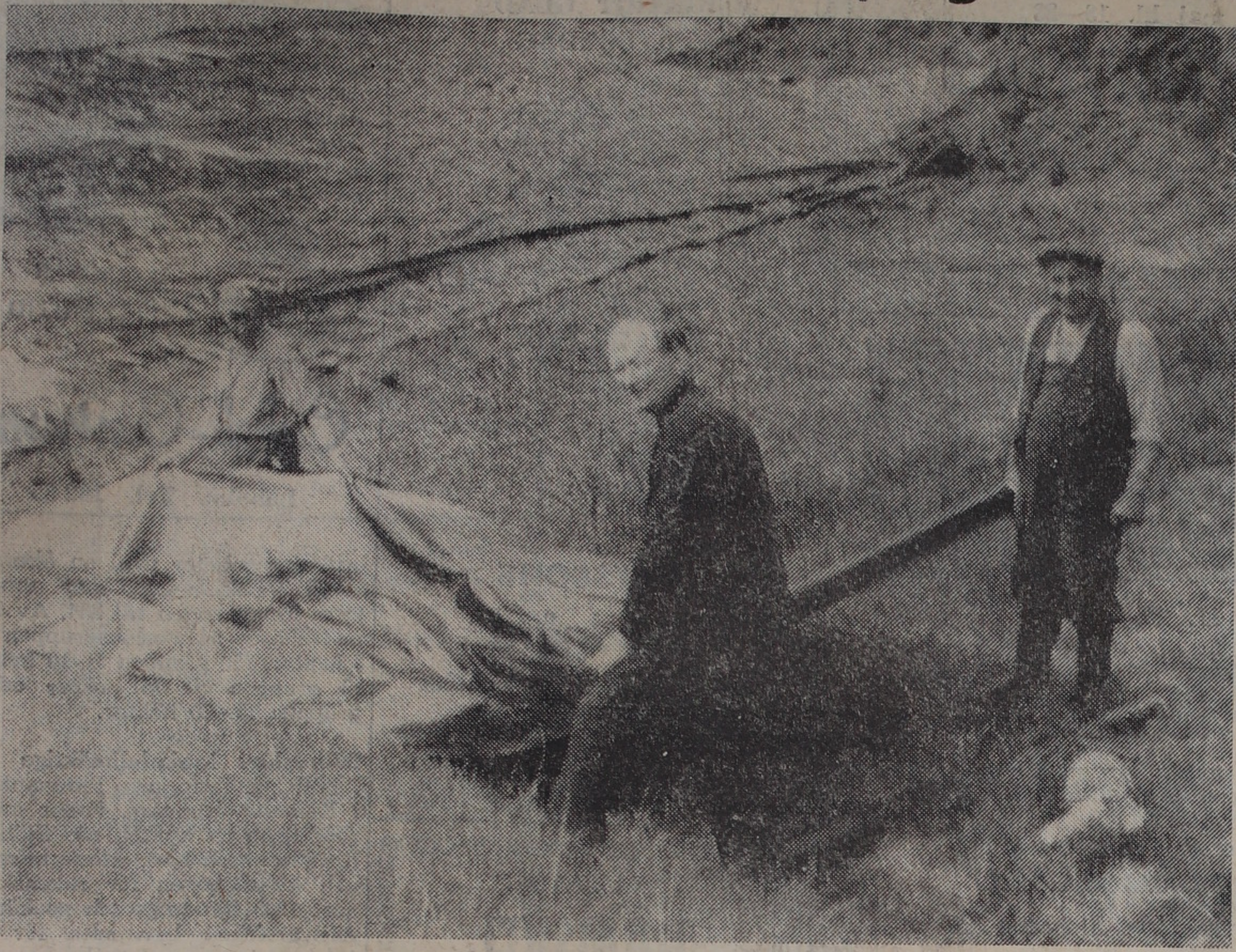
Här arbetar fr. v. Adolf Karlsson, Sven Nilsson och Joel Johansson med att lägga plastduk på botten
