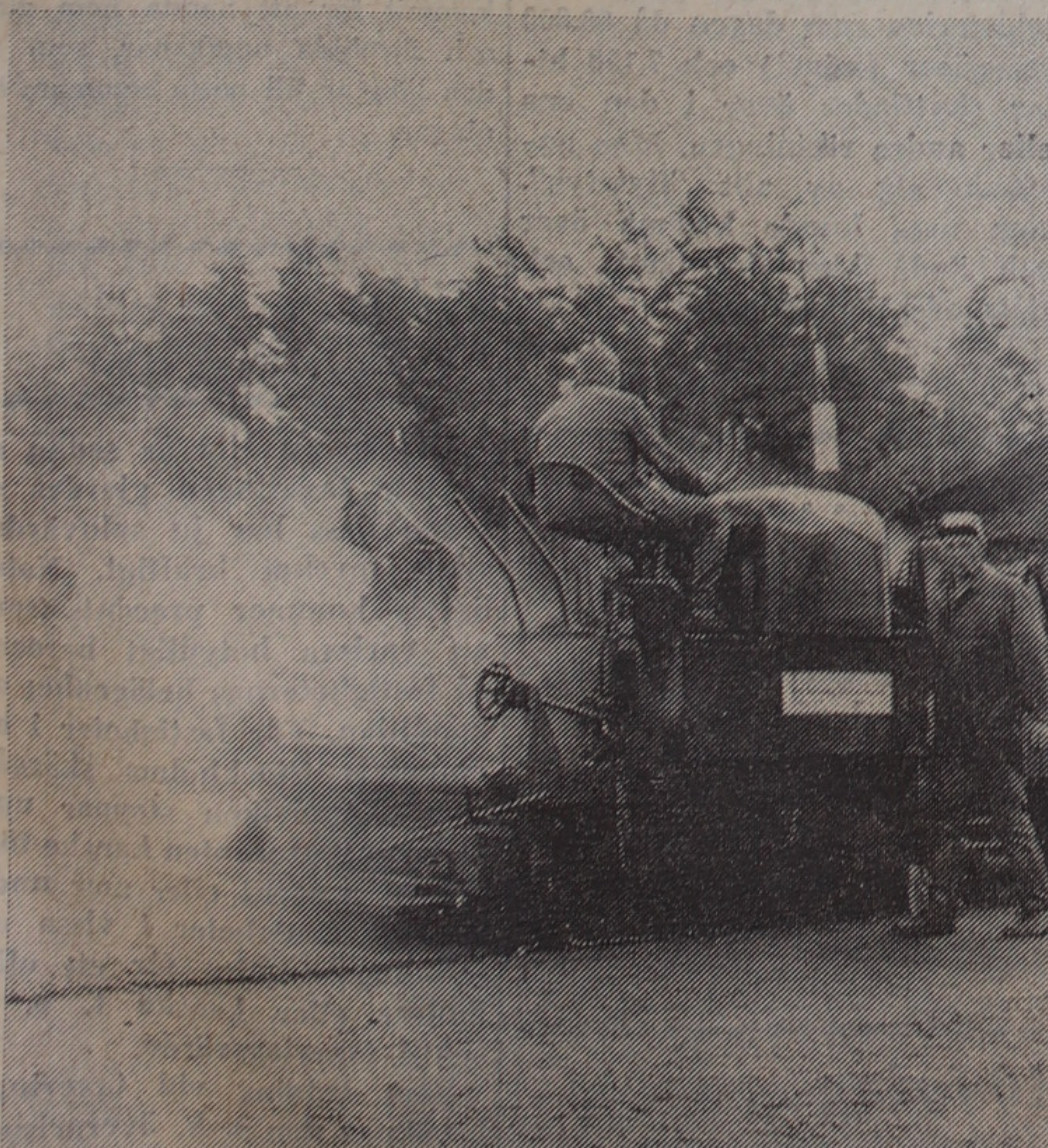
Utläggmaskinen i fullt arbete.
