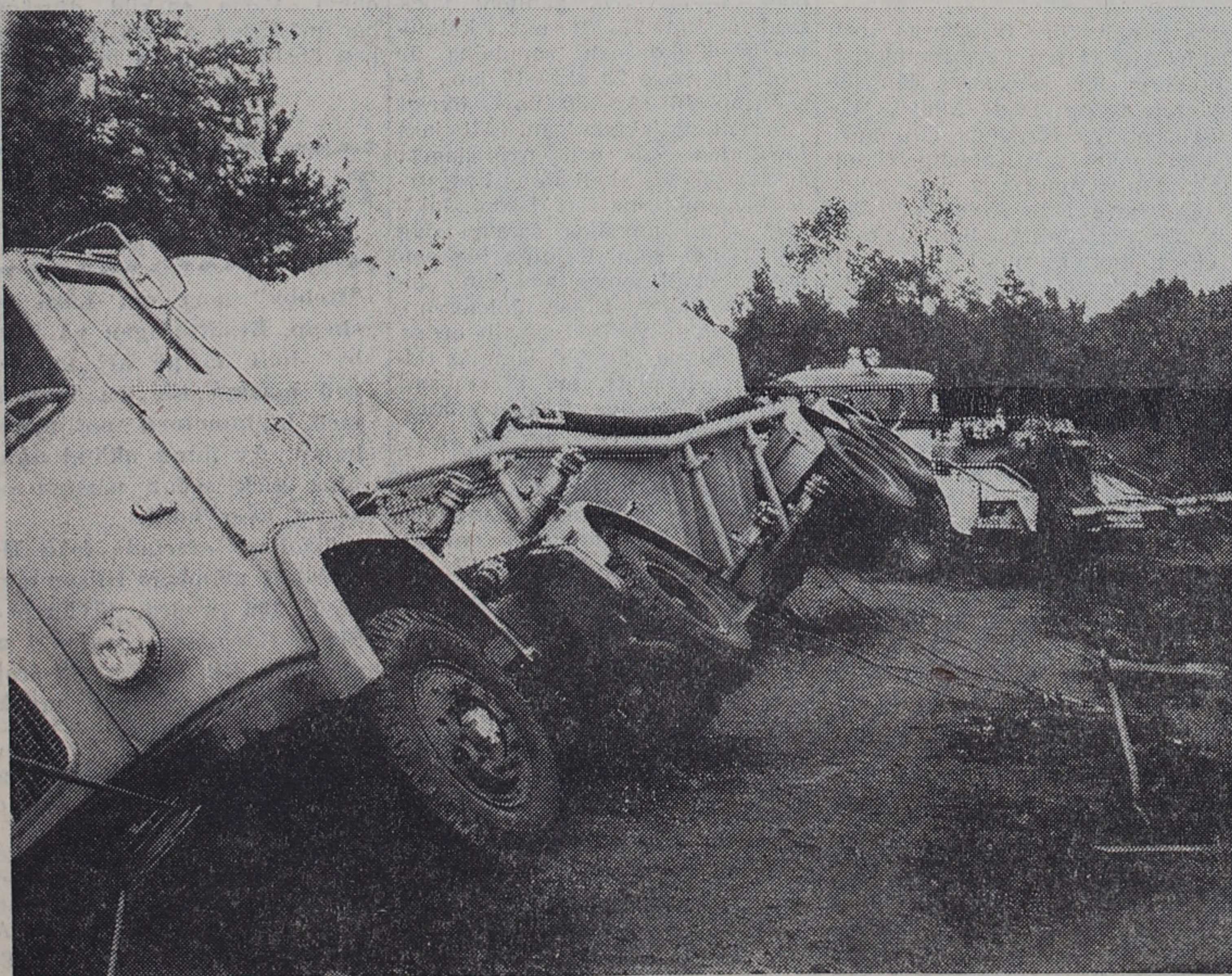
Den tungt lastade trailern sjönk djupt ned i mossen och bärgningsarbetet blev synnerligen komplicerat.
