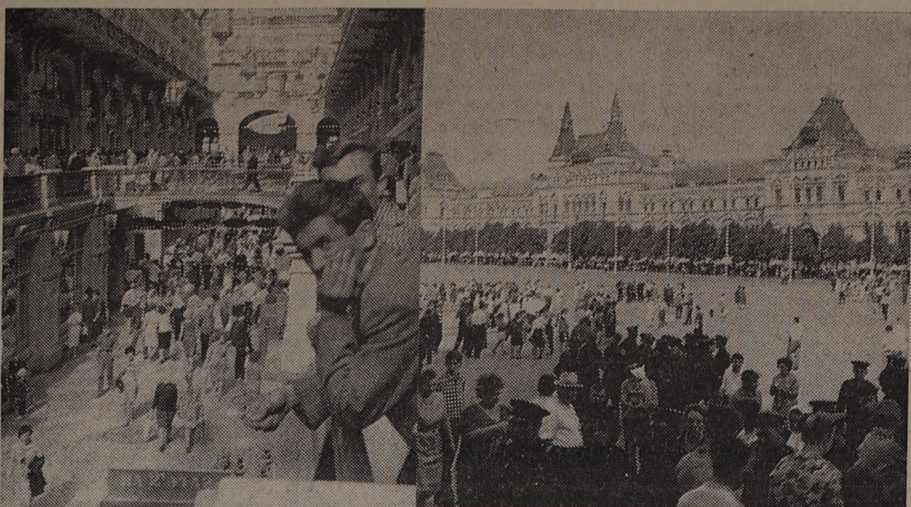
Det stora varnhuset Gom, interiör och exteriör
