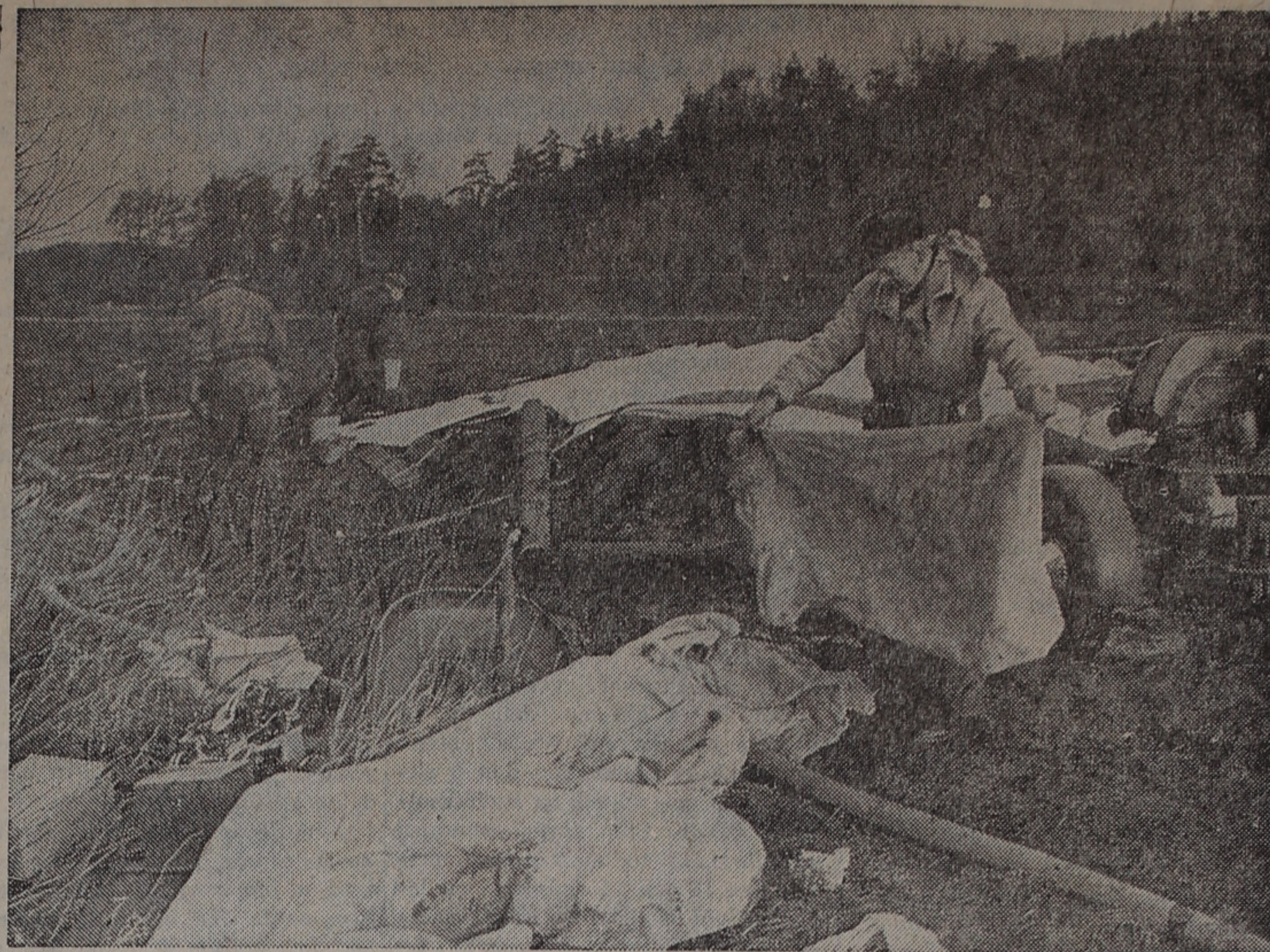
Arbetet med att pumpa undan smältvattnet från den översvämmade pupinboxen och reparera densamma var tidskrävande, men på söndagskvällen var arbetet klart och telefonlinjerna i funktion igen.
