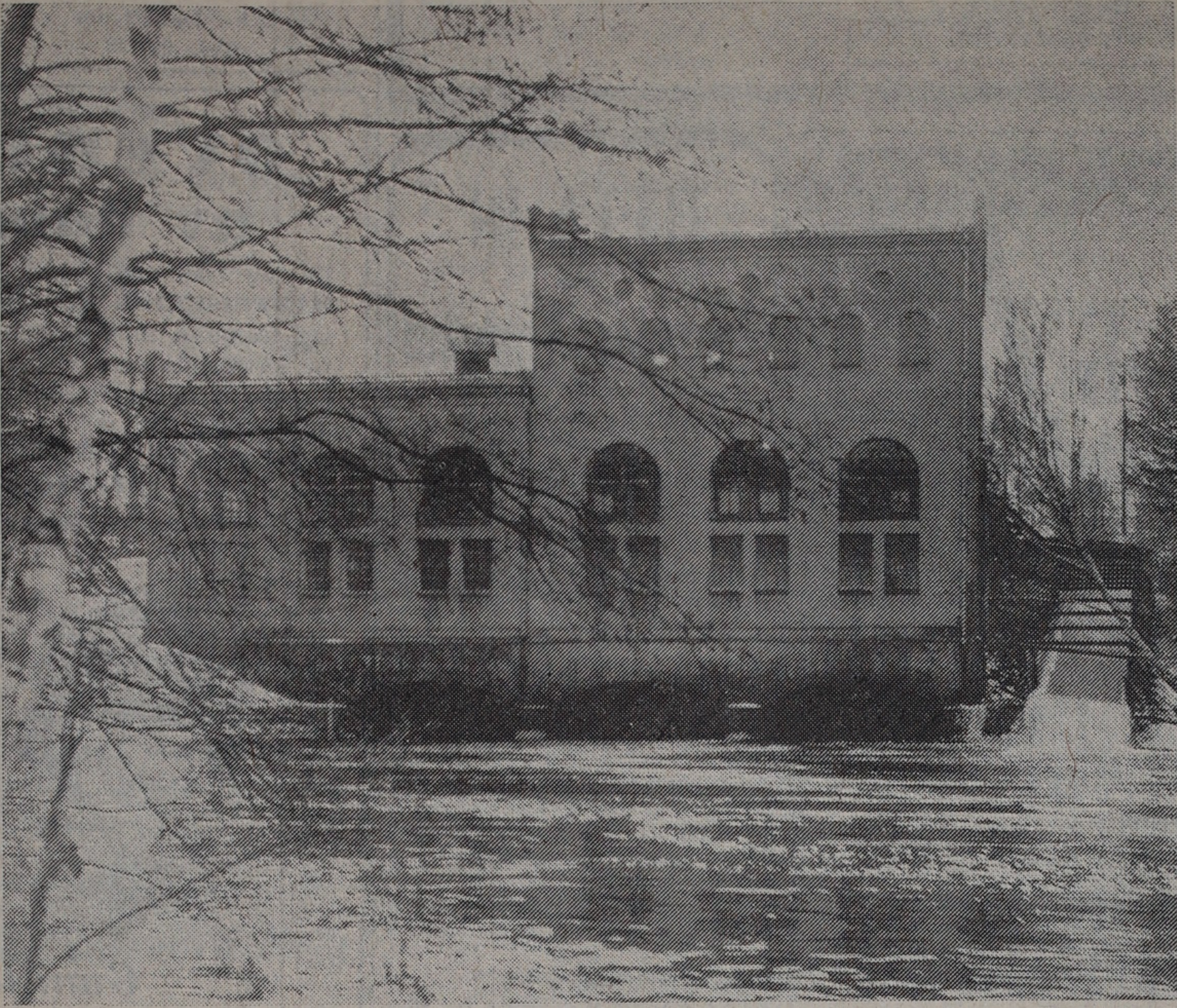
Ombyggnaderna av kraftverken i bl. a. Lagan kommer att ge Sydkraft bättre resurser att motsvara den ökade efterfrågan på elkraft. Här en bild av kraftverket i Knäred, som också kommer att beröras av ombyggnationerna
