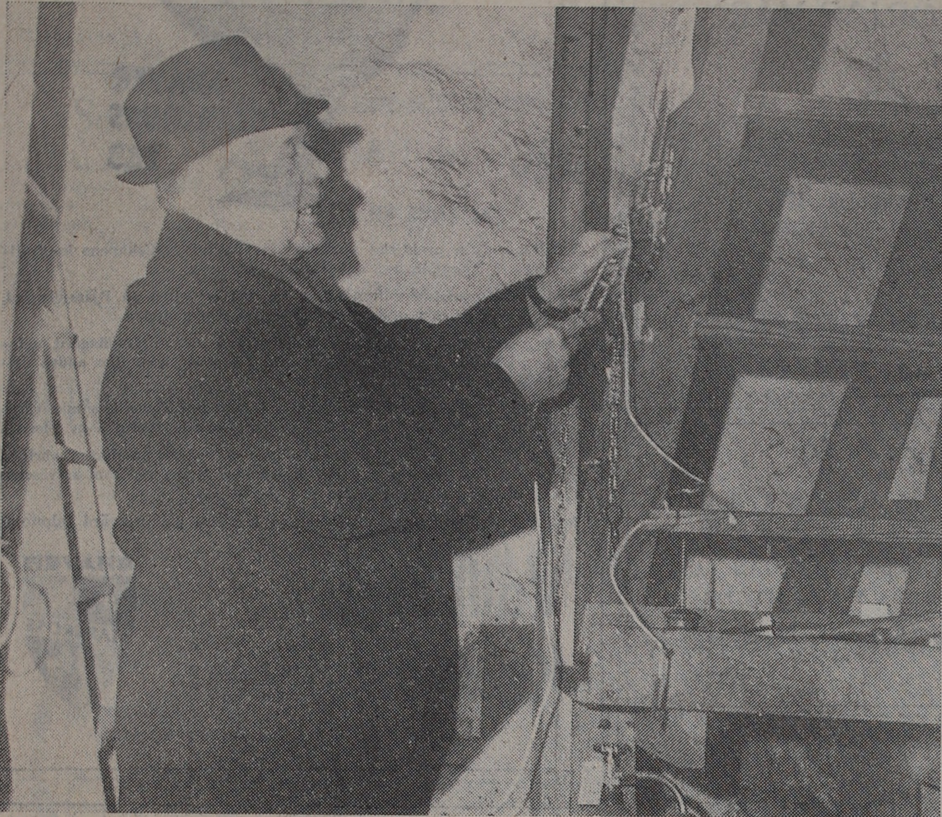
Kyrkoherde Arvid Hallind i Hasslöv demonstrerar sin uppfinning som medförde en besparing för församlingen på omkring 8.000 kr. Nu öppnar man och stänger tornluckorna lekande lätt från tornkammaren i bottenplanet och slipper springa i de allt annat än lättillgängliga trapporna i det höga tornet.
