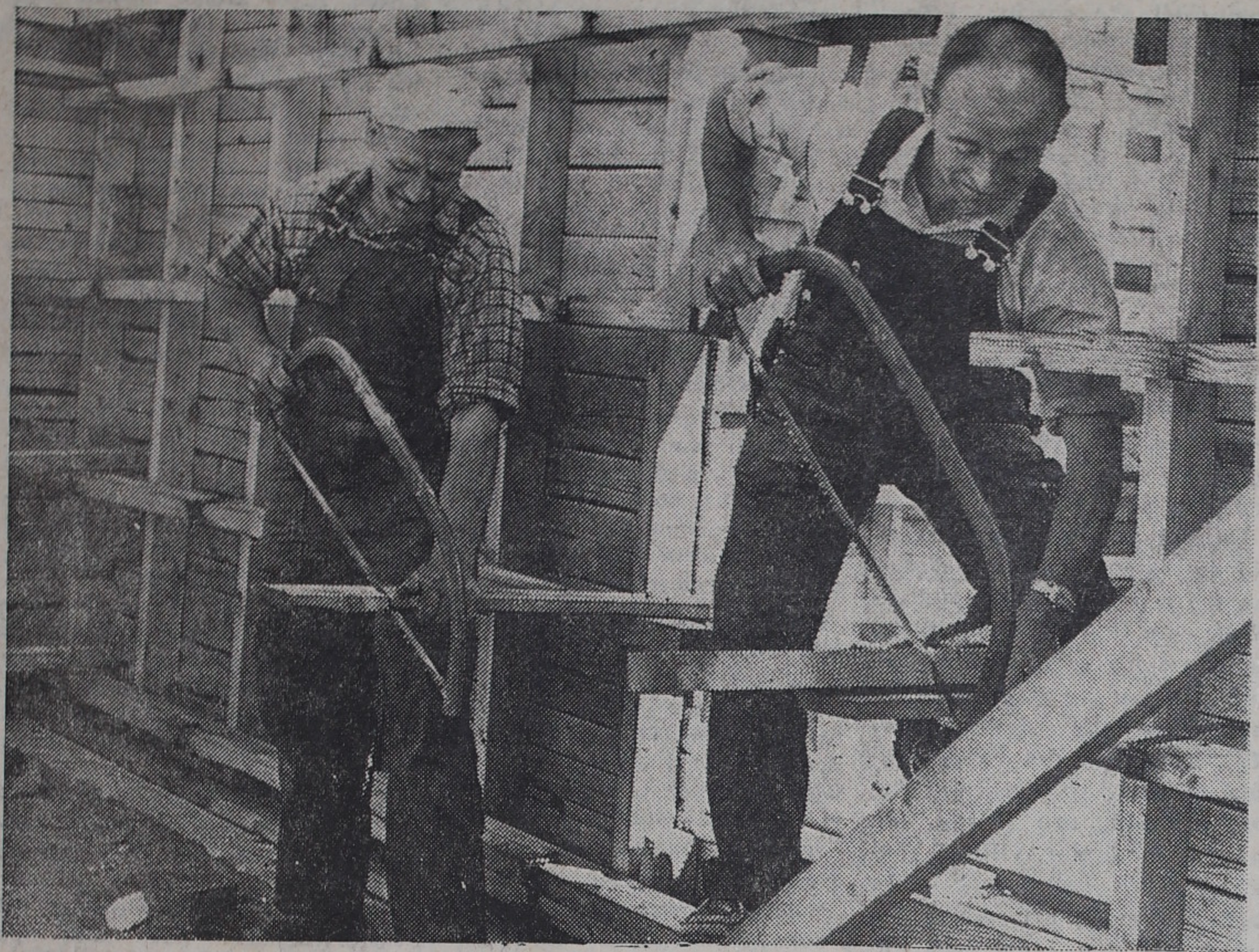
Några av arbetarna på hyreshuset. Fr. v. byggnadsnickarna Östen Johansson och Erik Nilsson, Laholm
