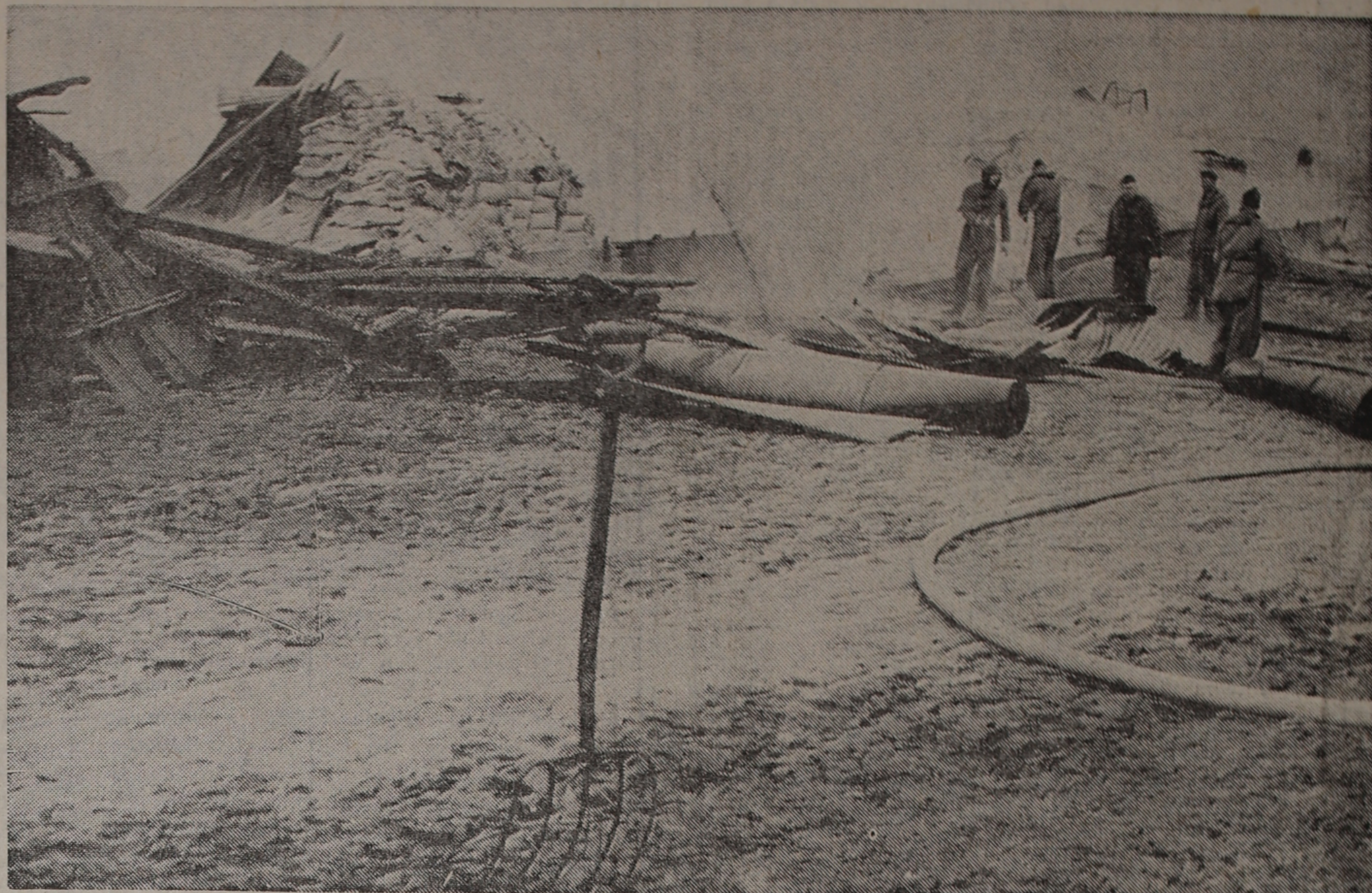
En kvart före tolv kallades Horreds brandkår till Fagerhult. Bilden ovan togs strax före klockan två, då var hela byggnaden nedbrunnen. Brandsoldaterna ovan drar fram takplåtarna ur glöderna för att blottlägga brandhärden och avsluta släckningsarbetet.
