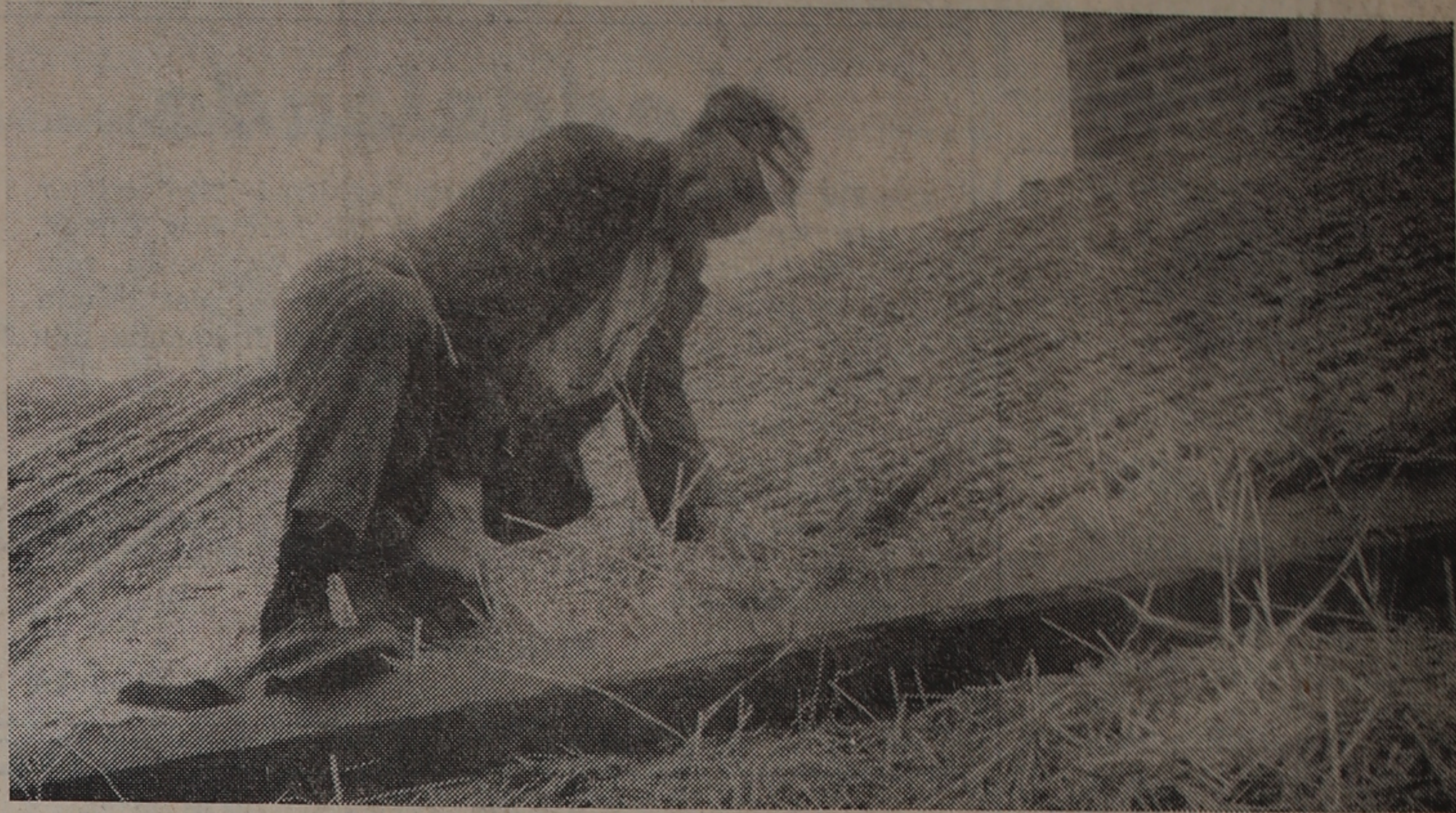
Här ligger Johan Nilsson och klipper till det nya taket. Med bra halm kan ett sänt här tak hålla i 40 år! Vanligtvis ligger det 110-15.
