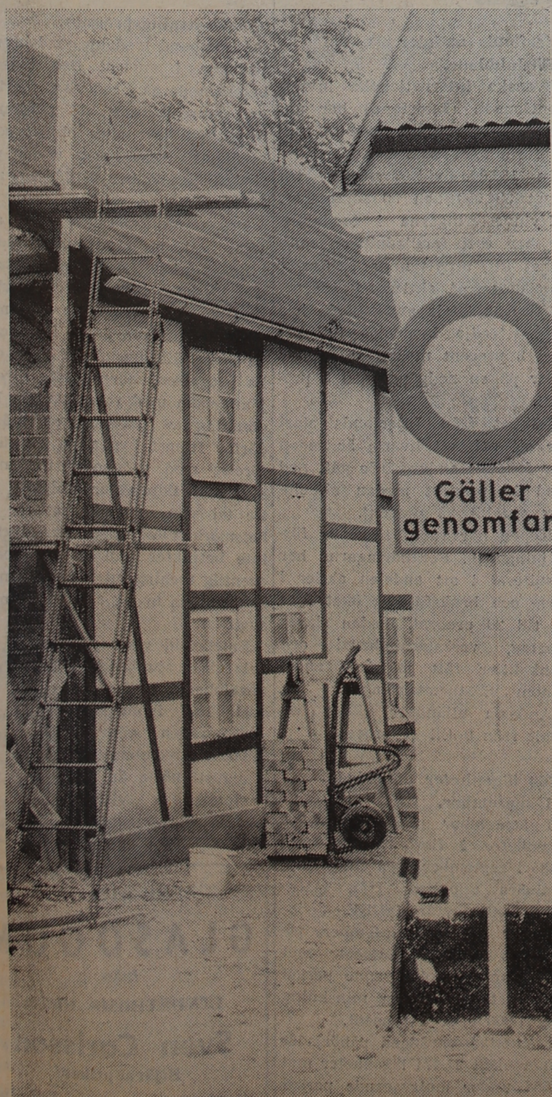
1800-talshuset på Evas gränd i Gamleby genomgår för närvarande en yttre renovering.
