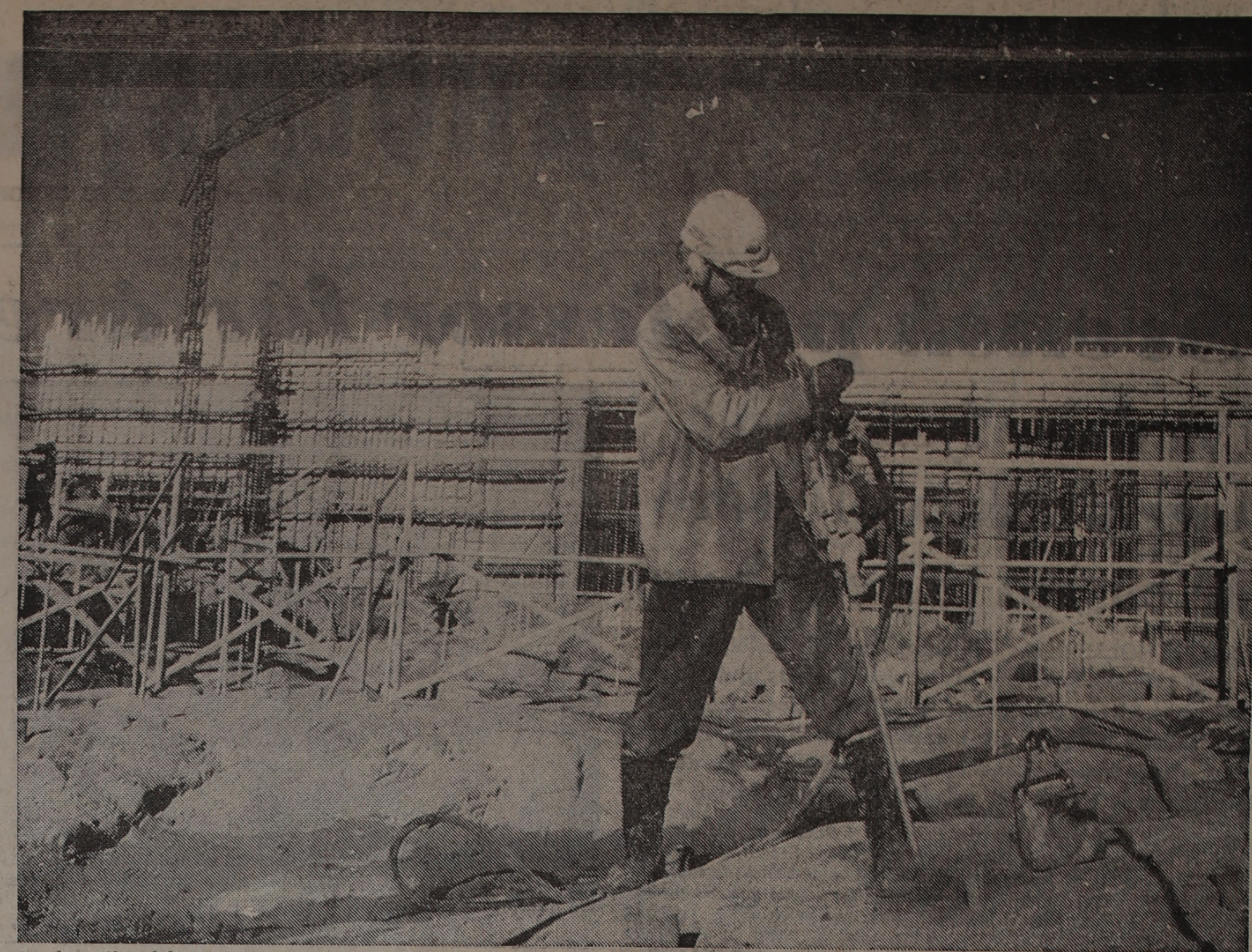
Byggnaden till sodahuset har kommit ett stycke på väg. Nästa steg här blir resningen av stålkonstruktionerna. Omfattande grundläggningsarbeten pågår inom hela området.
